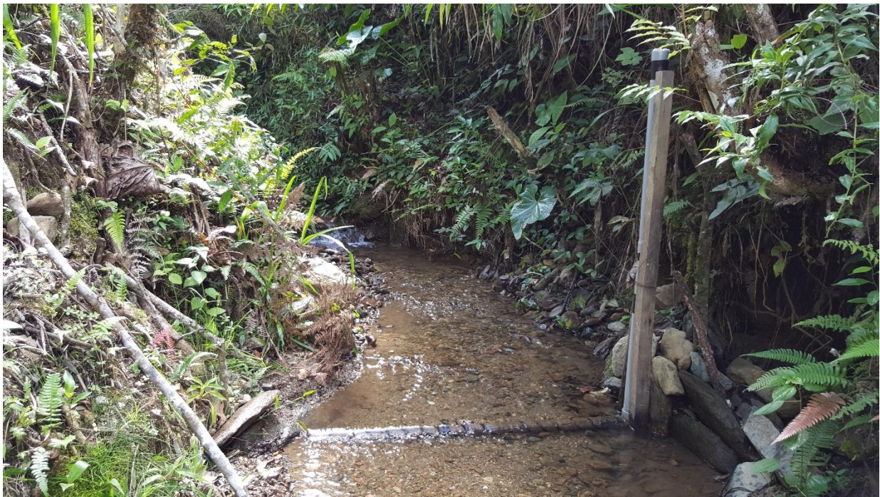
Figura 26. Sensor de nivel de agua Odyssey instalado
