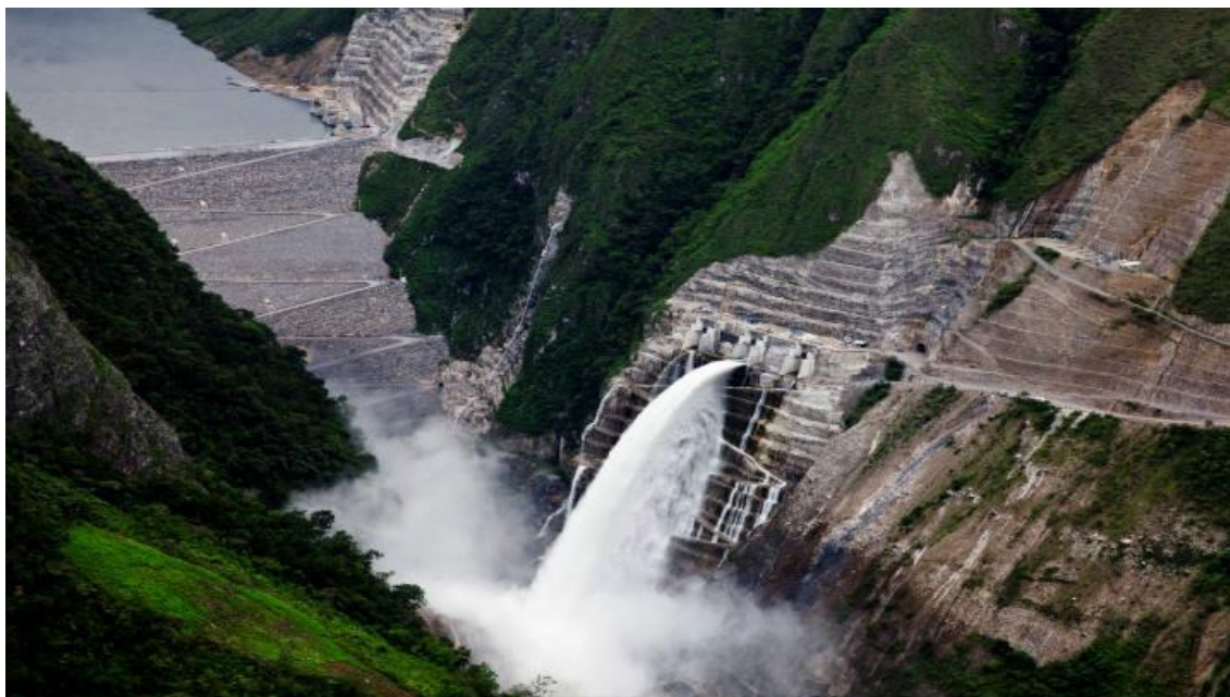
Figura 11. Vista panorámica de la presa en la Central Hidroeléctrica Chaglla
