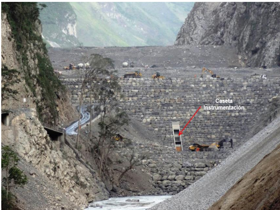
Figura 25. Fotografía que muestra el relleno de la Presa y la caseta de instrumentación.
