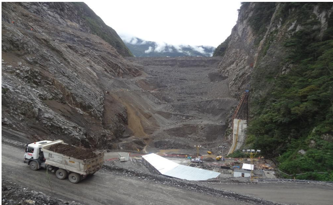
Figura 26. Fotografía en mayo del 2014, que se observa el relleno de la Presa en la cota 1147.72 m.s.n.m.
