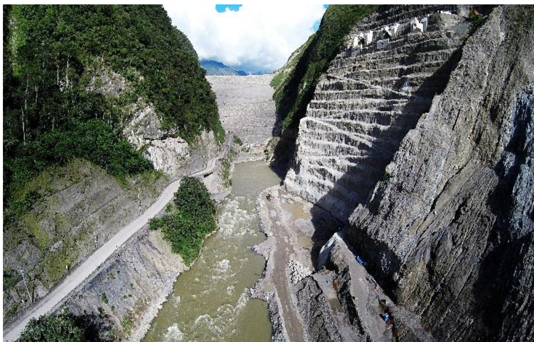
Figura 28 Fotografía en mayo del 2015, Se observa la Presa culminada.
