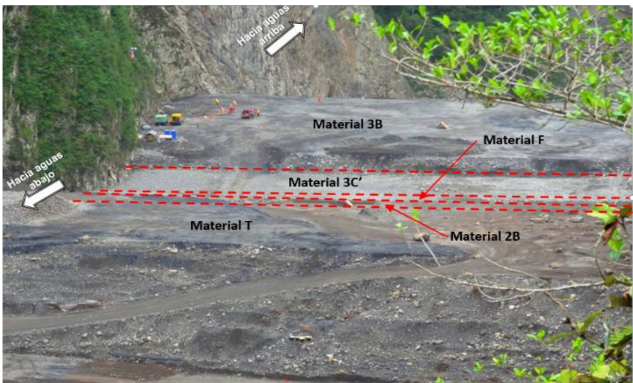
Figura 21. Colocación por tipo de Materiales en el relleno de Presa
