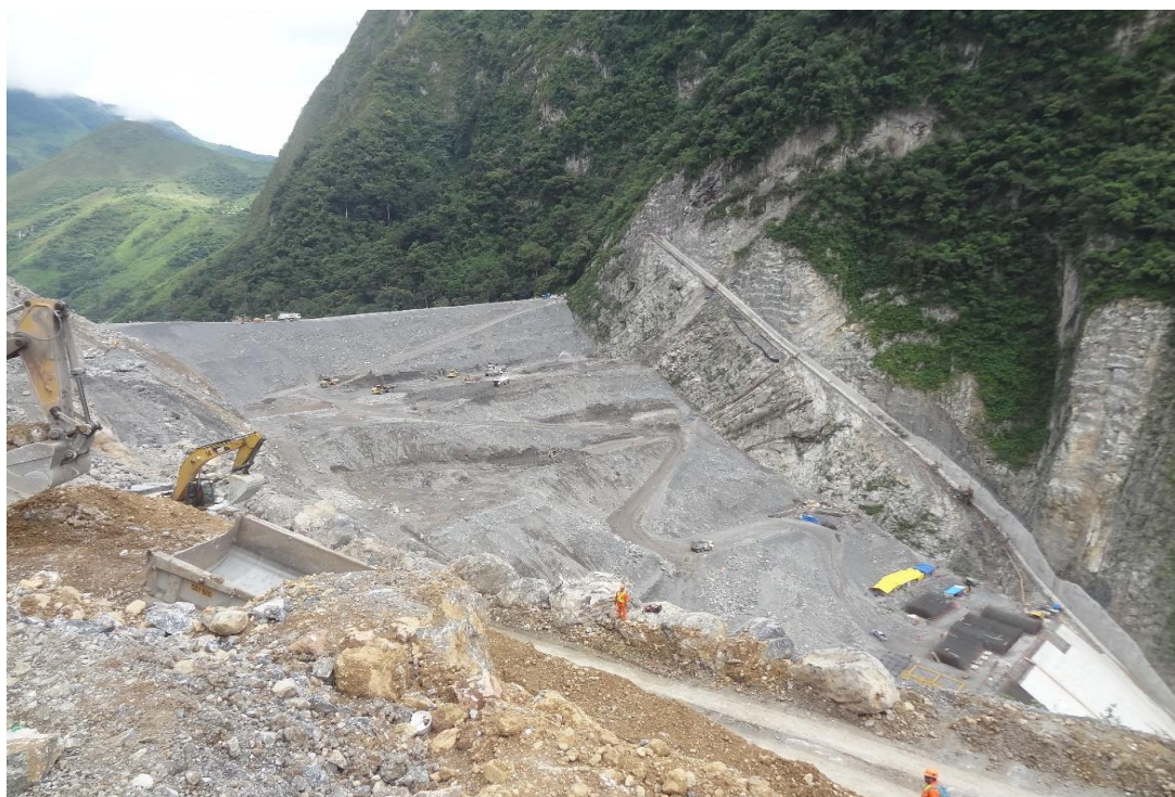
Figura 27. Fotografía en diciembre del 2014 que se observa el relleno de la Presa en la cota 1116.22 m.s.n.m.
