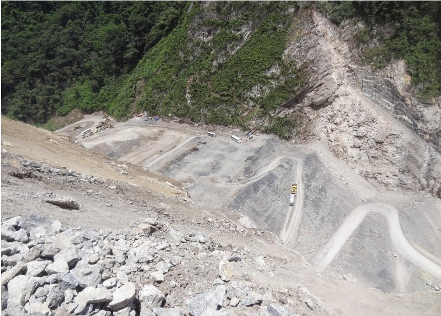
Figura 24. Fotografía Se observa el relleno de la Presa a fines del 2013.
