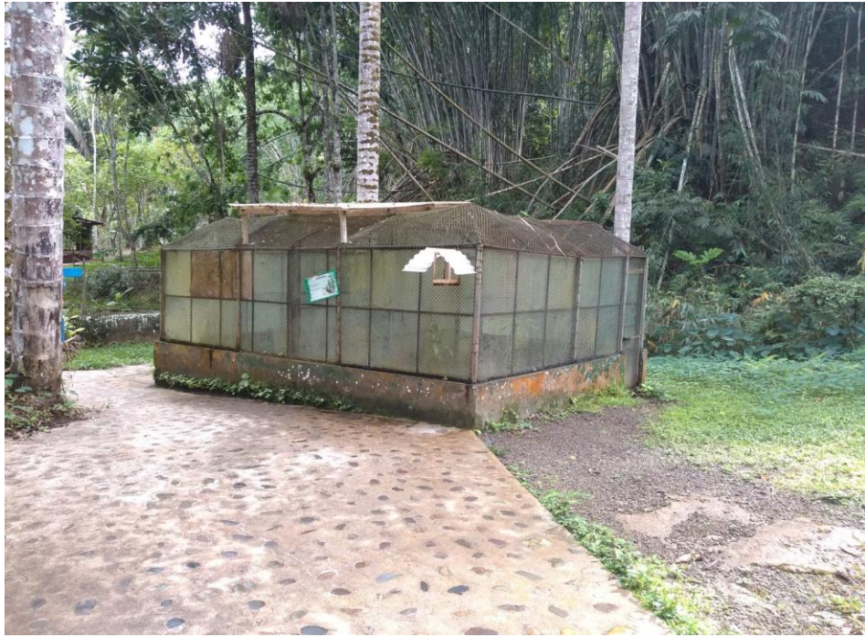
Figura 77. Área 3– Caseta de las tortugas
