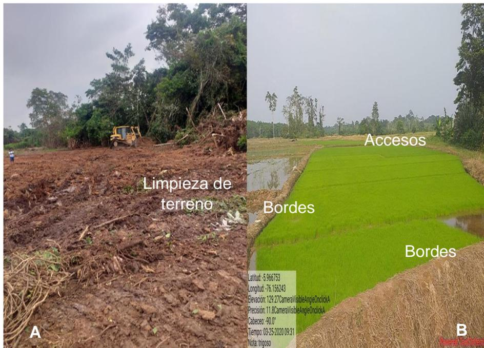
**Figura 2.** Limpieza del terreno (A), construcción de bordes, accesos y drenes (B)
