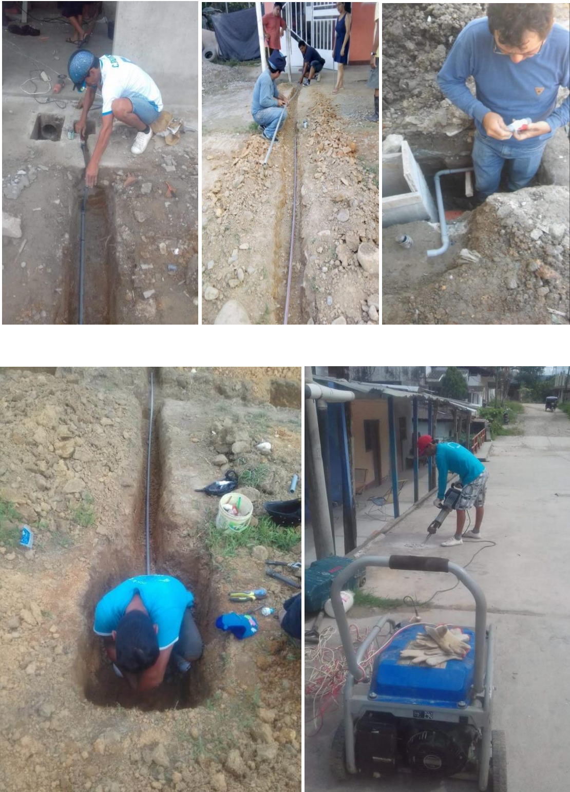
Figura 42. Trabajos de instalaciones nuevas del servicio de agua, solicitados por nuevos usuarios.
