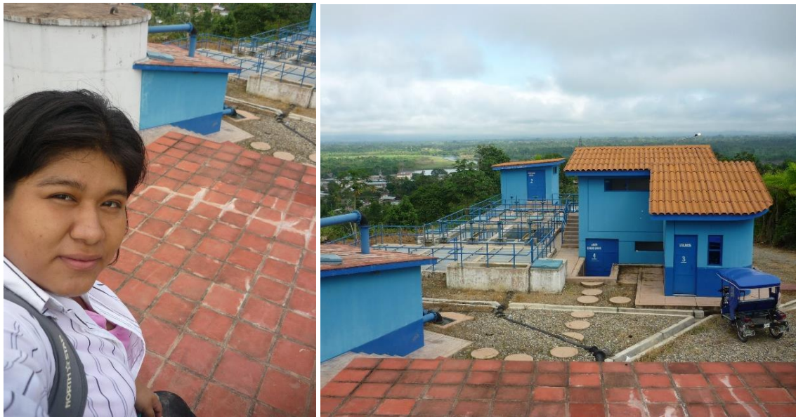
Figura 26. Vista panorámica de la planta de tratamiento de agua potable de la localidad de Nuevo Progreso.
