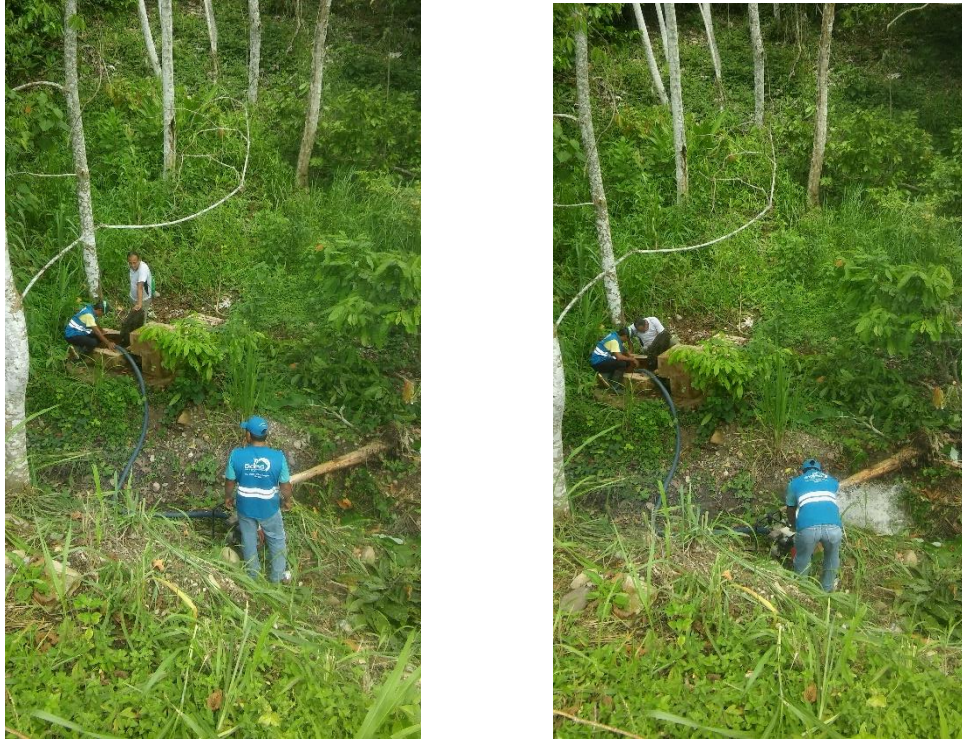
Figura 27. Mantenimiento de la tubería de conducción de agua cruda.
