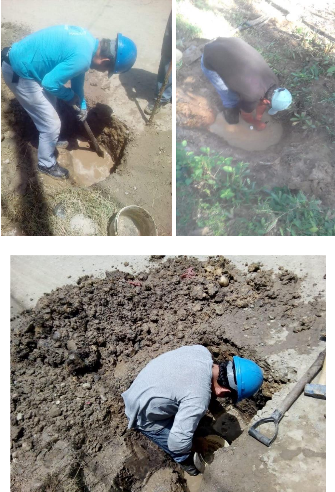
Figura 41. Trabajos de clausura de conexiones clandestinas de agua potable.
