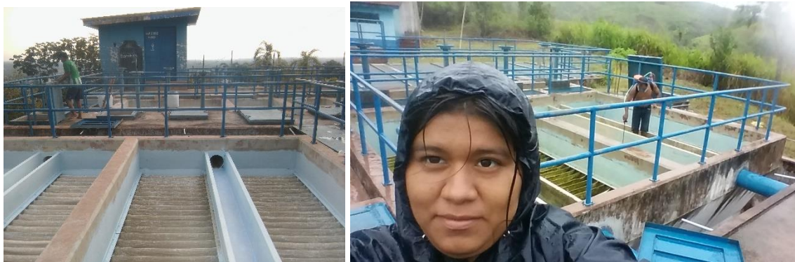
Figura 21. Finalizando el trabajo en la planta de tratamiento de agua potable.
