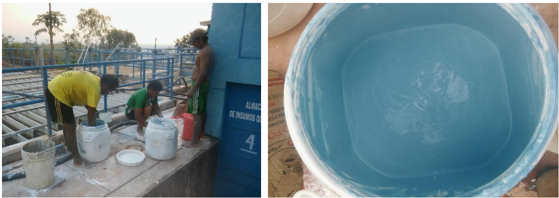
Figura 20. Preparación de insumos para la desinfección y el pintado de las paredes interiores de los componentes de la planta de tratamiento.
