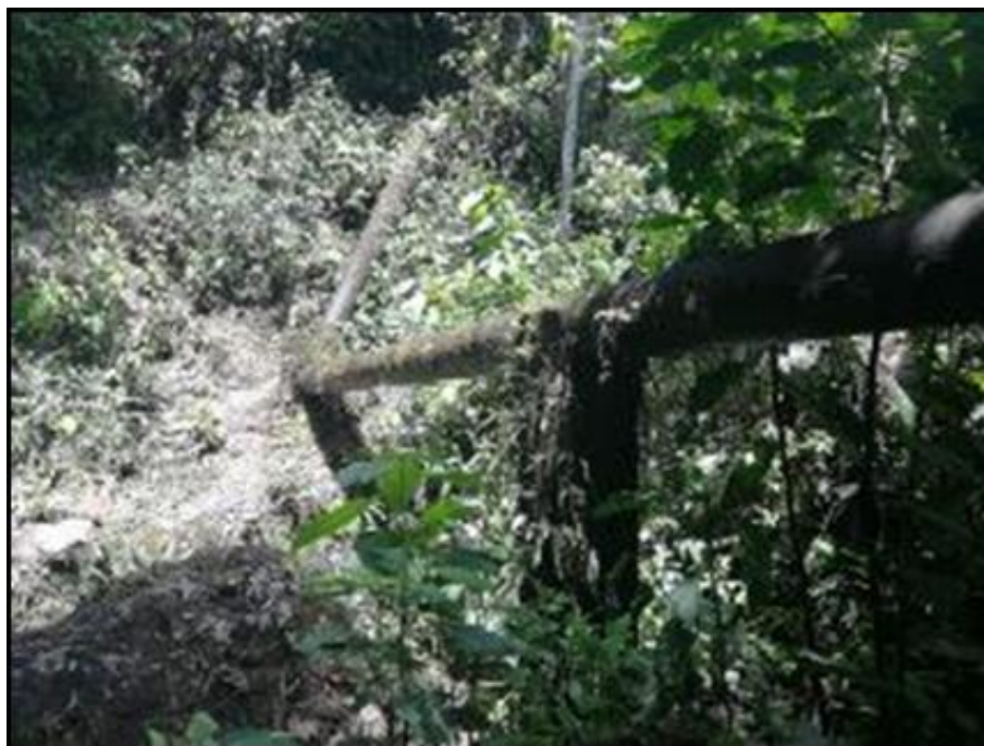
Figura 4. Se muestra el cruce de la LC-02 por quebradas, apoyada sobre dados de concreto y columnas.
