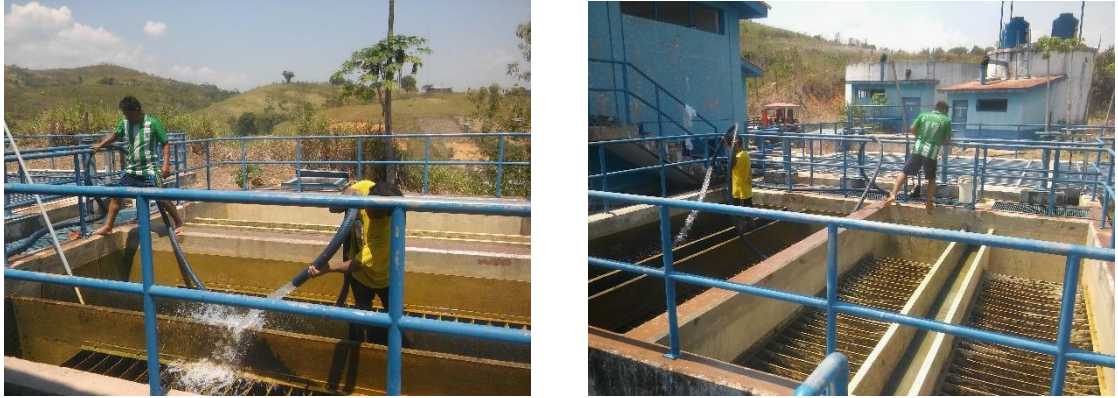
Figura 19. Personal operacional realizando la limpieza y desinfección de los sedimentadores.
