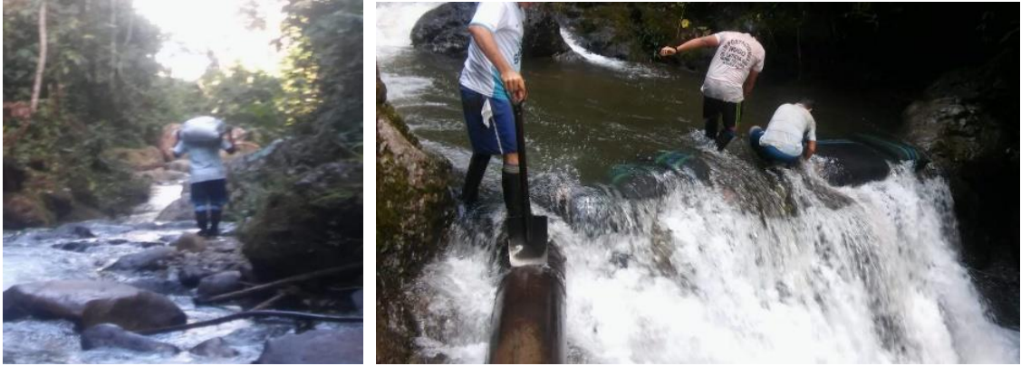
Figura 34. Trabajos de mantenimiento en la captación, donde el personal técnico realiza el represamiento en la Quebrada Cañutillo.
