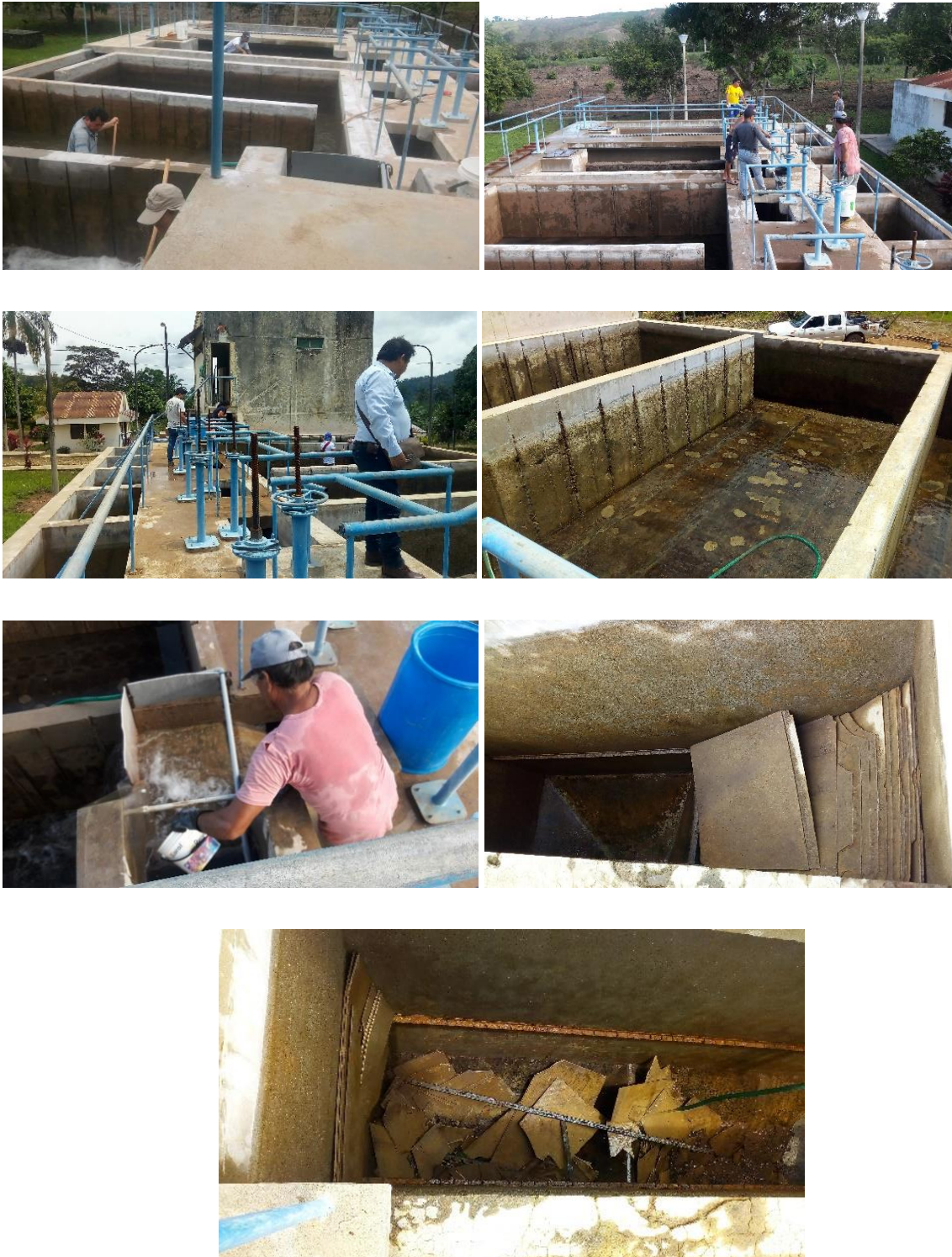
Figura 31. Visita general de la planta de tratamiento de agua potable en el sector Yacusisa, con el equipo técnico, para la evaluación del estado situacional del sistema de abastecimiento de la localidad de Tocache.
