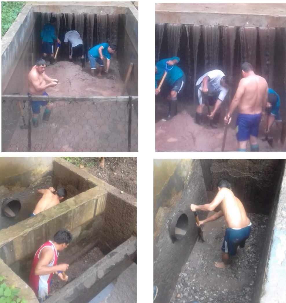
Figura 35. Trabajos de limpieza y descolmatación del desarenador en el sector Roca Fuerte, como parte de la programación mensual.
