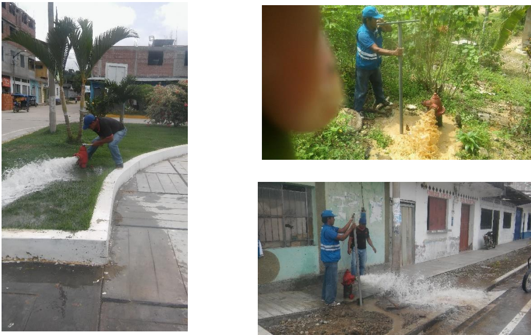
Figura 28. Mantenimiento de las redes de distribución en la ciudad de Nuevo Progreso, a través de los hidrantes ubicados en diferentes puntos.
