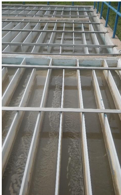
Figura 18. Etapa de floculación del agua para su tratamiento.
