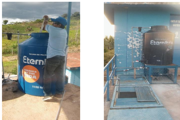
Figura 24. Preparación y aplicación de insumos químicos.
