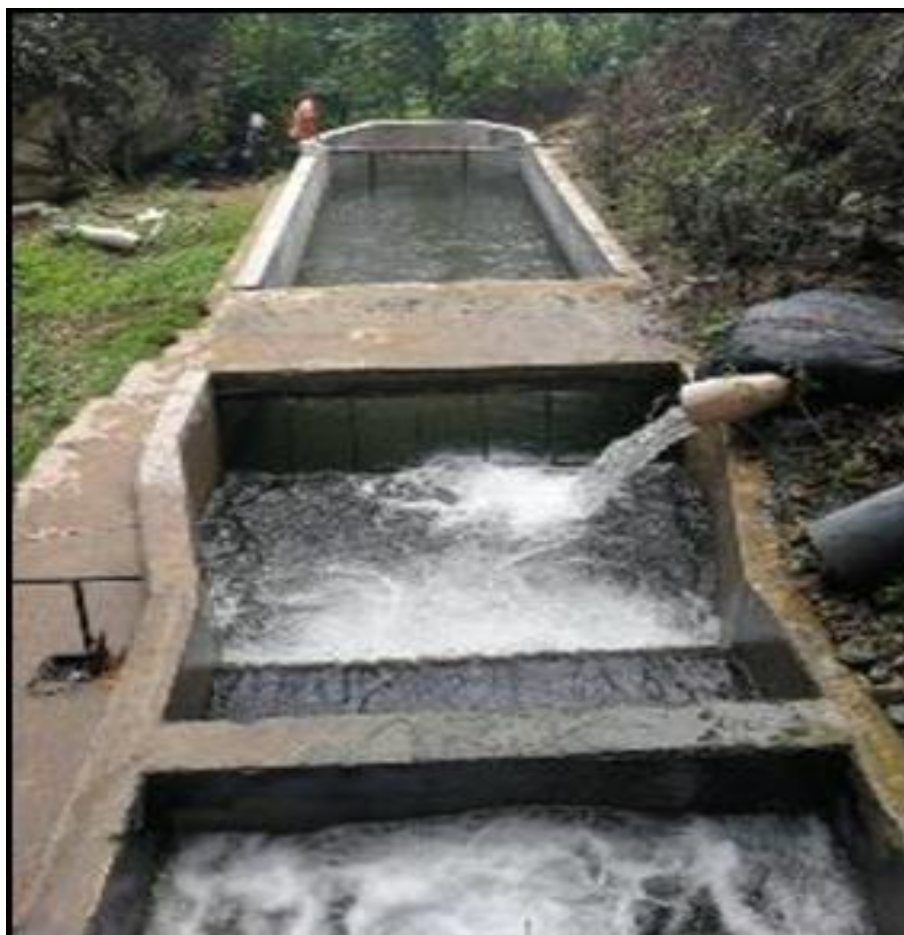
Figura 3. Desarenador existente.
