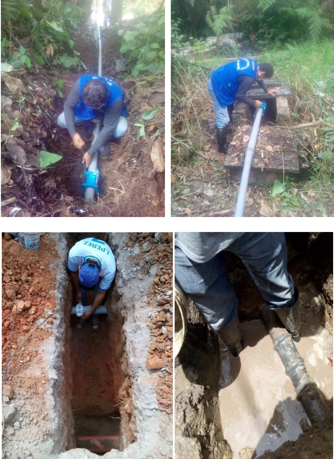
Figura 38. Personal técnico realizando trabajos de mantenimiento y reparación de las redes de distribución primaria y secundaria de agua potable en la ciudad.
