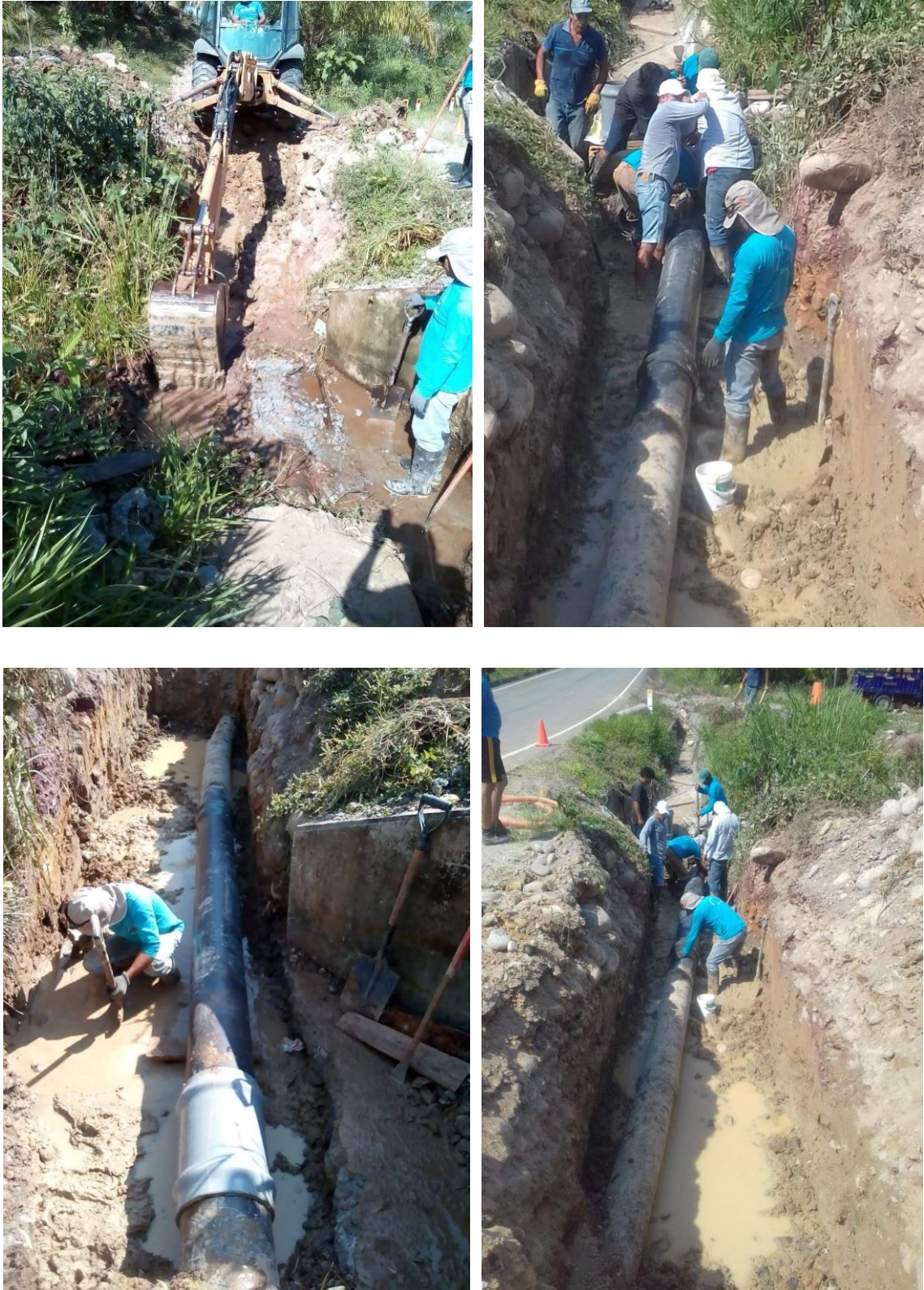
Figura 39. Personal técnico realizando trabajos de reparación de la tubería de conducción de 315 y 250 mm de diámetro en el sector Yacusisa.
