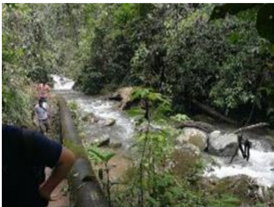
Figura 1. Captación de agua en la quebrada Rocafuerte.
