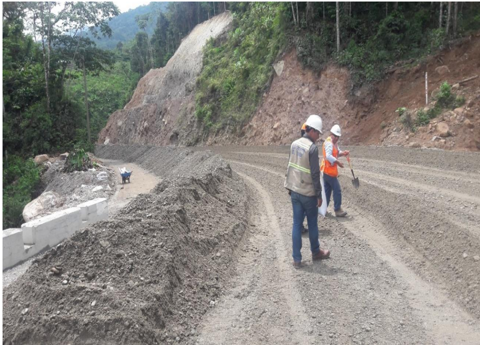
Figura 36. Muestreo de Material de Pista (Corona) – Sub Rasante
