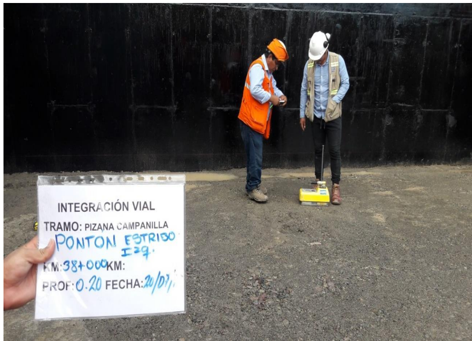
Figura 45. Relleno Estructural de Estribos de Pontón
