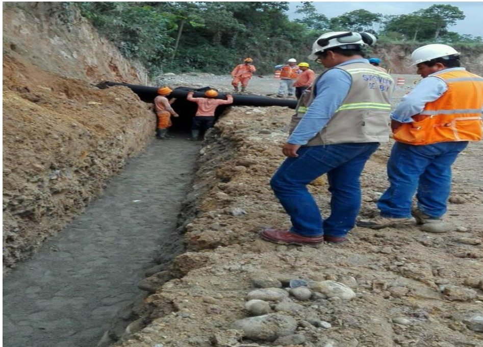
Figura 43. Conformación de Material para Ejecución de Sub Drenes
