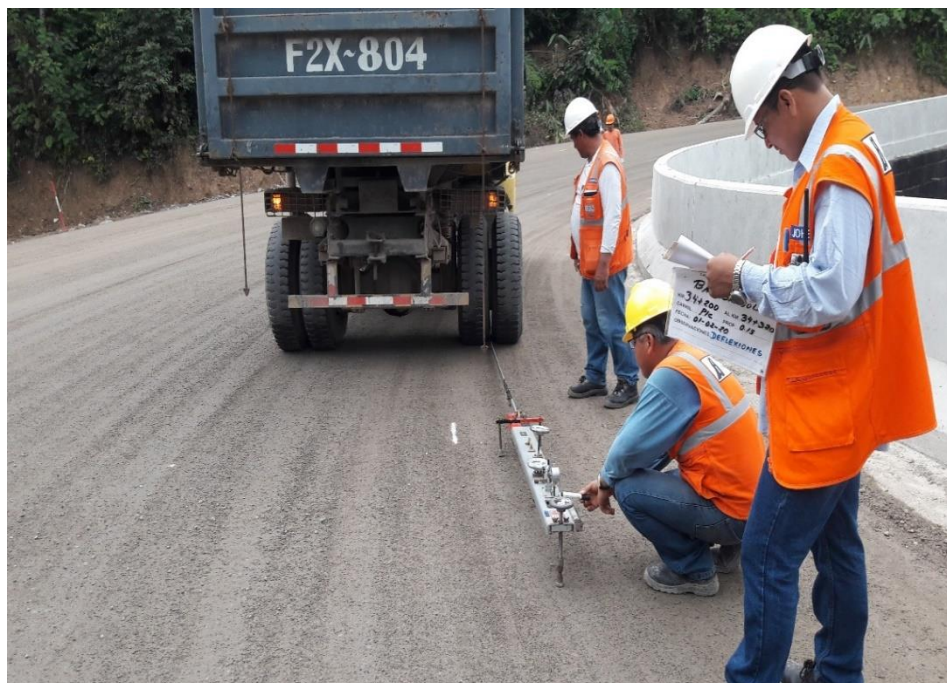
Figura 51. Ensayo de Deflexiones a Nivel de Base Granular.
