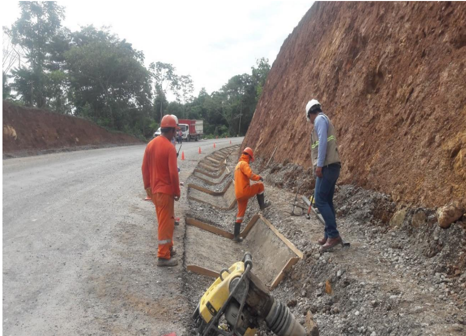
Figura 44. Conformacion de Material para Ejecucion de Cunetas
