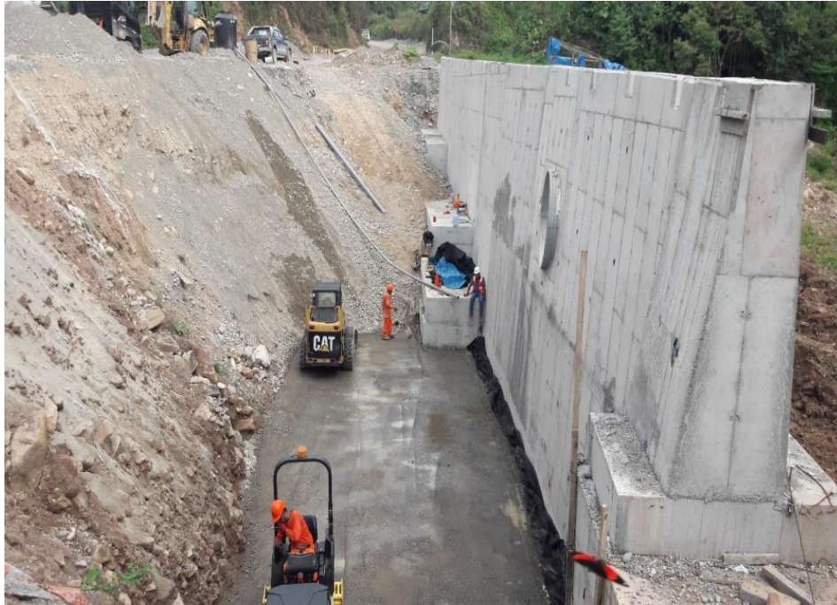
Figura 41. Relleno Estructural y Compactación de Muros con Material de Corona
