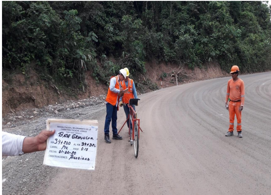
Figura 48. Ensayo de Índice de Regularidad Superficial con Equipo Merlín a Nivel de Base Granular.
