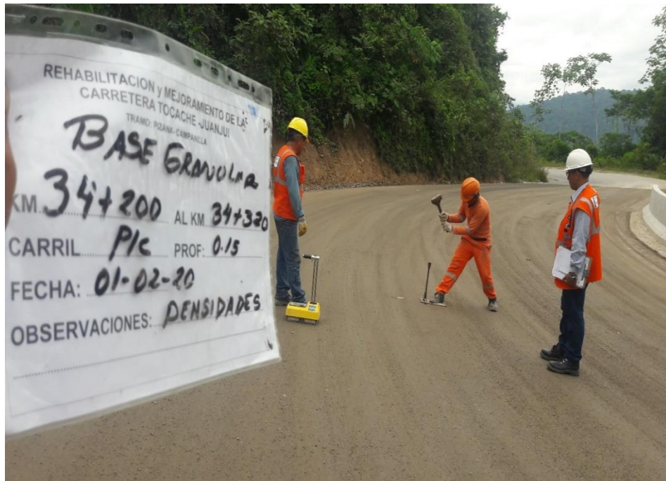
Figura 50. Ensayo de Compactación a Nivel de Base Granular
