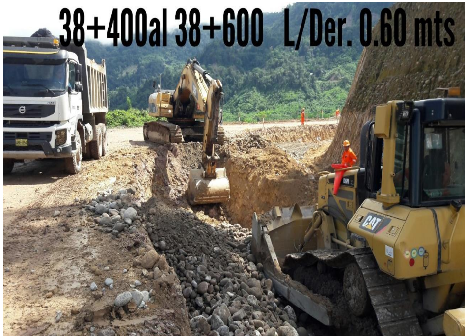
Figura 35. Excavación para Mejoramientos de Plataforma
