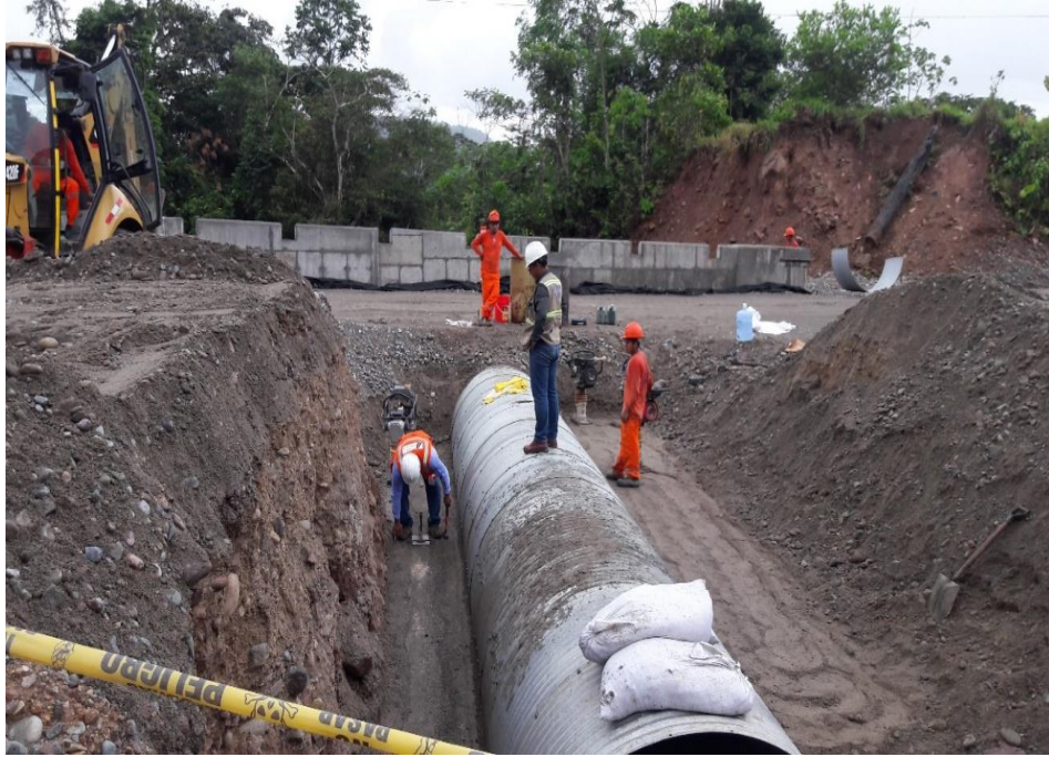
Figura 42. Relleno Estructural y Compactación de Alcantarillas con Material de Corona
