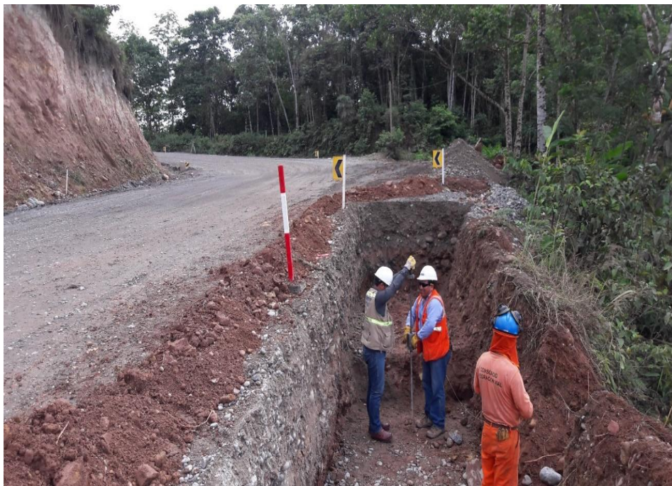
Figura 38. Ensayo de Penetrómetro Dinámico Ligero (DPL) – para Muros Concreto Armado y Concreto Ciclopio.
