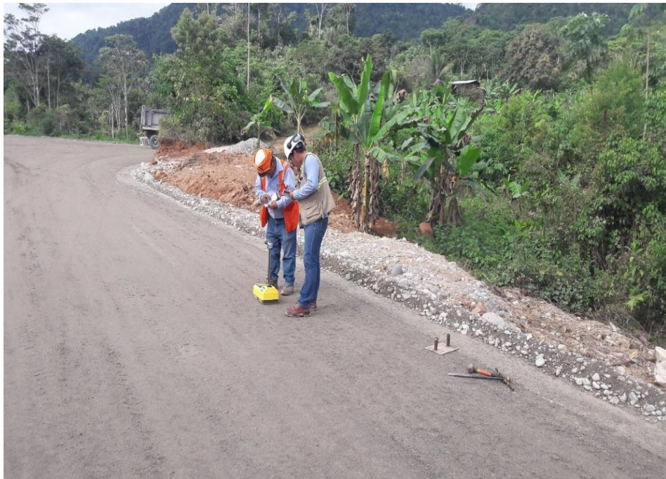
Figura 47. Ensayo de Compactación a Nivel de Sub Rasante
