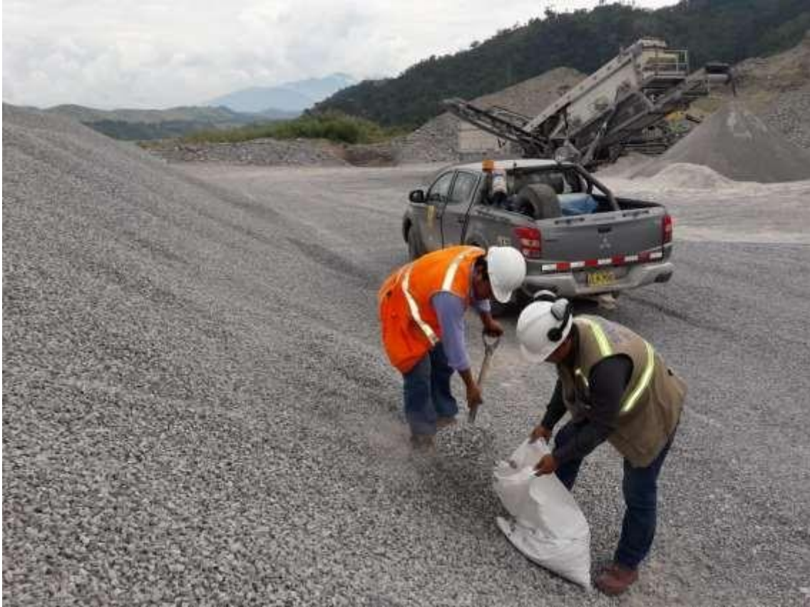
Figura 14. Material de terraplén en conformación de plataforma
