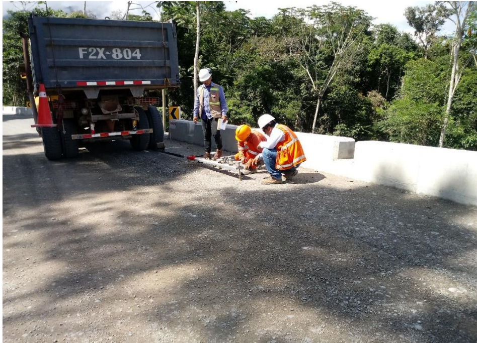
Figura 46. Ensayo de Deflexiones a Nivel de Sub Rasante 2da Capa
