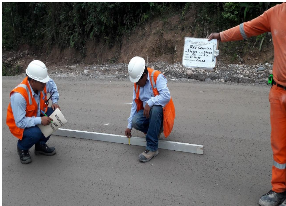
Figura 49. Ensayo de Uniformidad de Superficie a Nivel de Base Granular
