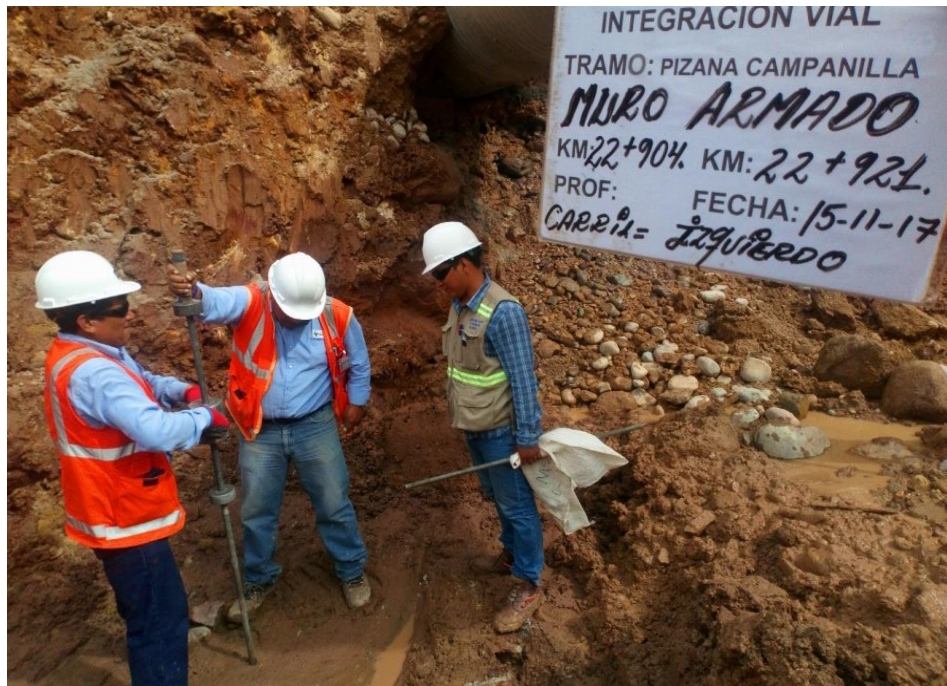
Figura 37. Ensayo de Penetrómetro Dinámico Ligero (DPL) – para Muros Concreto Armado y Concreto Ciclopio.
