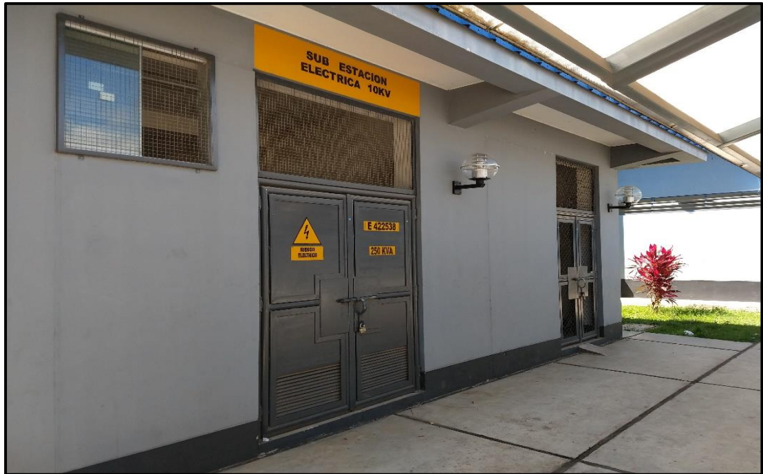
Figura 19. Sub Estación Eléctrica de la I.E.E. Gómez Arias Dávila; Elaboración Propia
