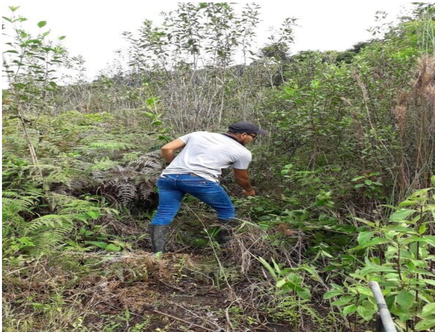
Figura 23. Limpieza del terreno donde se realizará la investigación
