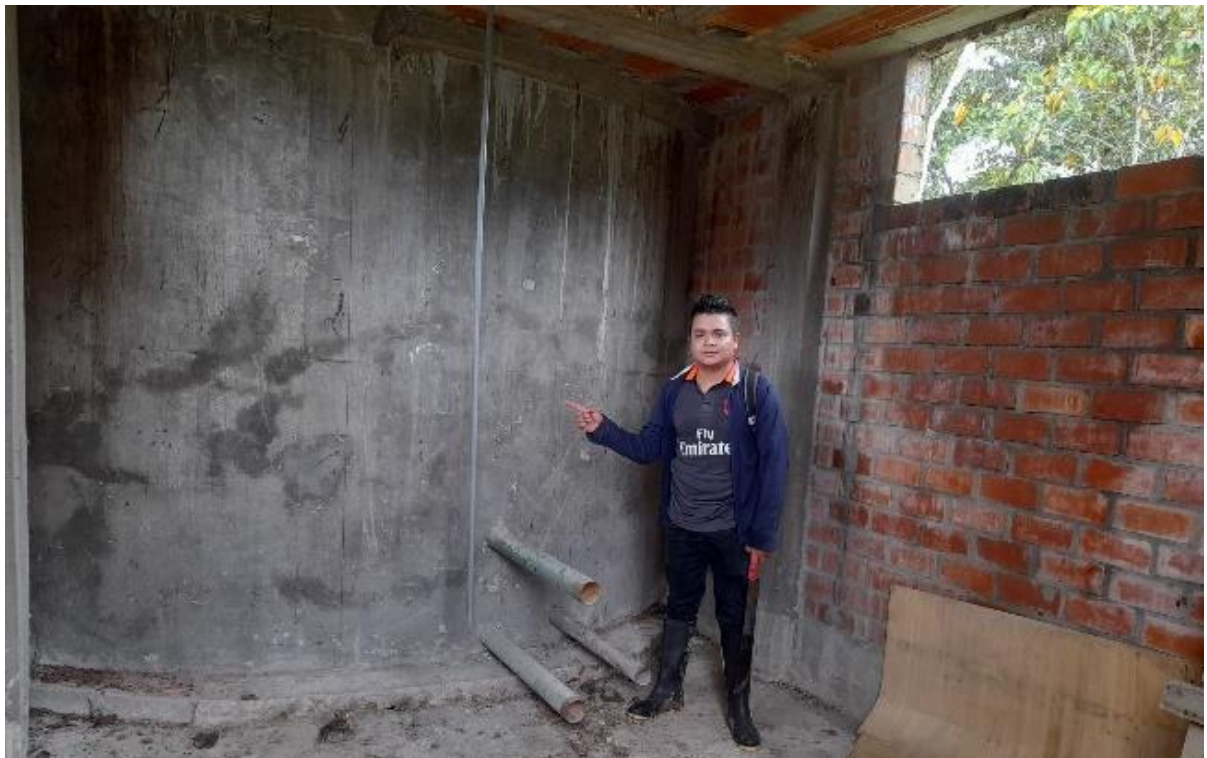
Figura 10 Caseta de válvulas del reservorio de Cayumba.
