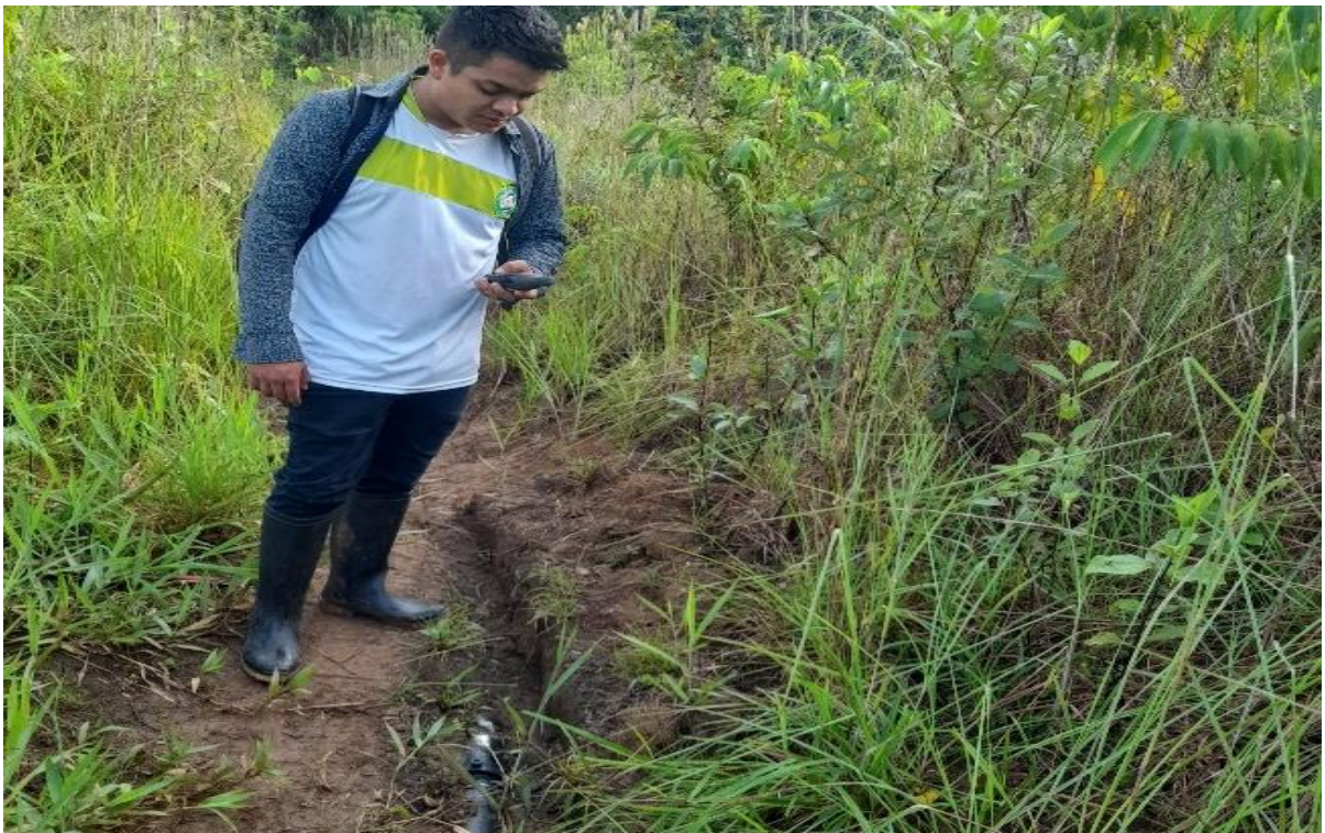
Figura 14. Válvula de purga.
