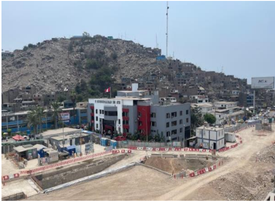
Figura 30. Vista de la Municipalidad Distrital de Ate colindante con las obras de la Línea 2 del metro de Lima y Callao
