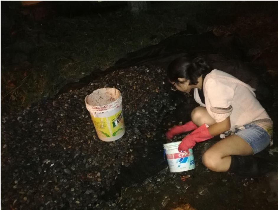
Figura 12. Selección de grava apta para el filtro biológico
