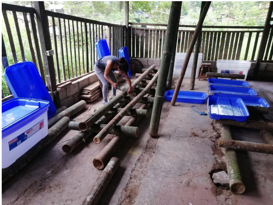
Figura 9. Construcción del sistema acuapónico
