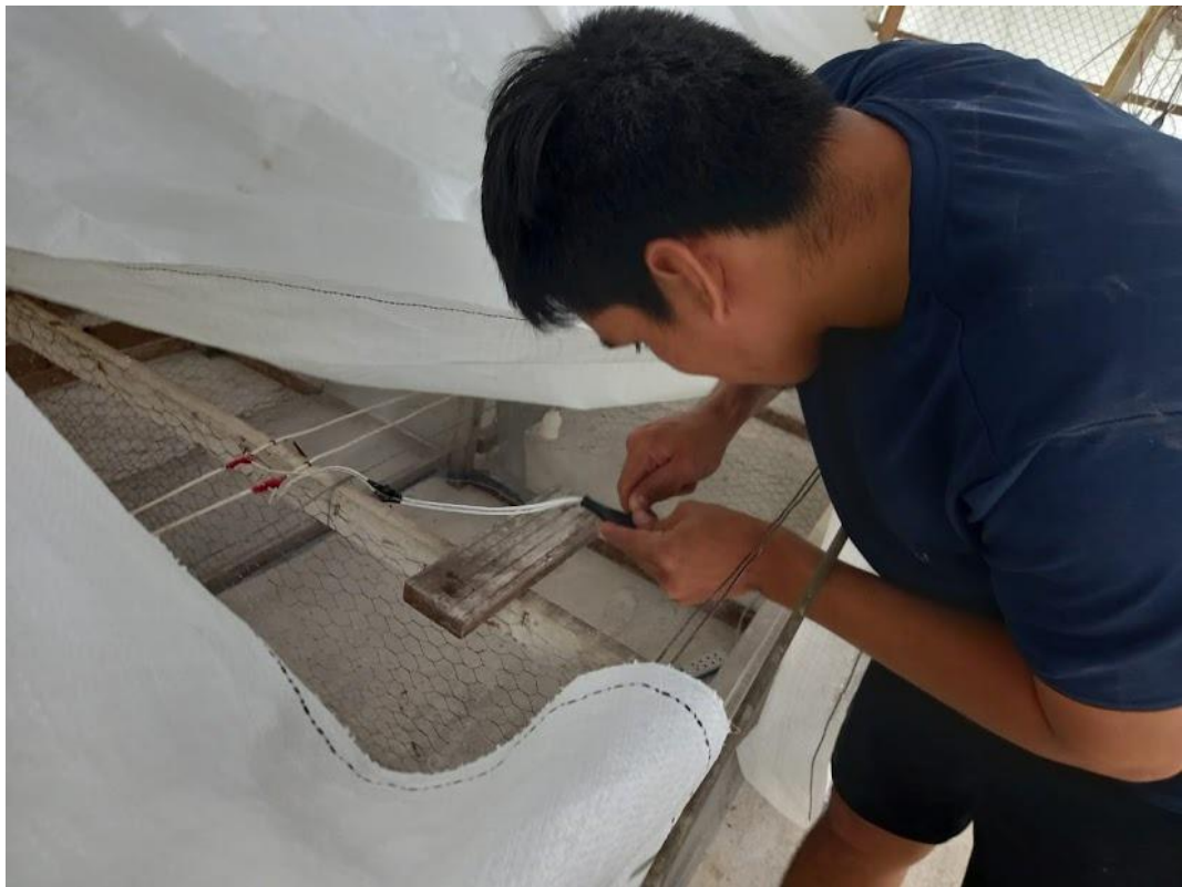
Figura 4. Instalación de luz.
