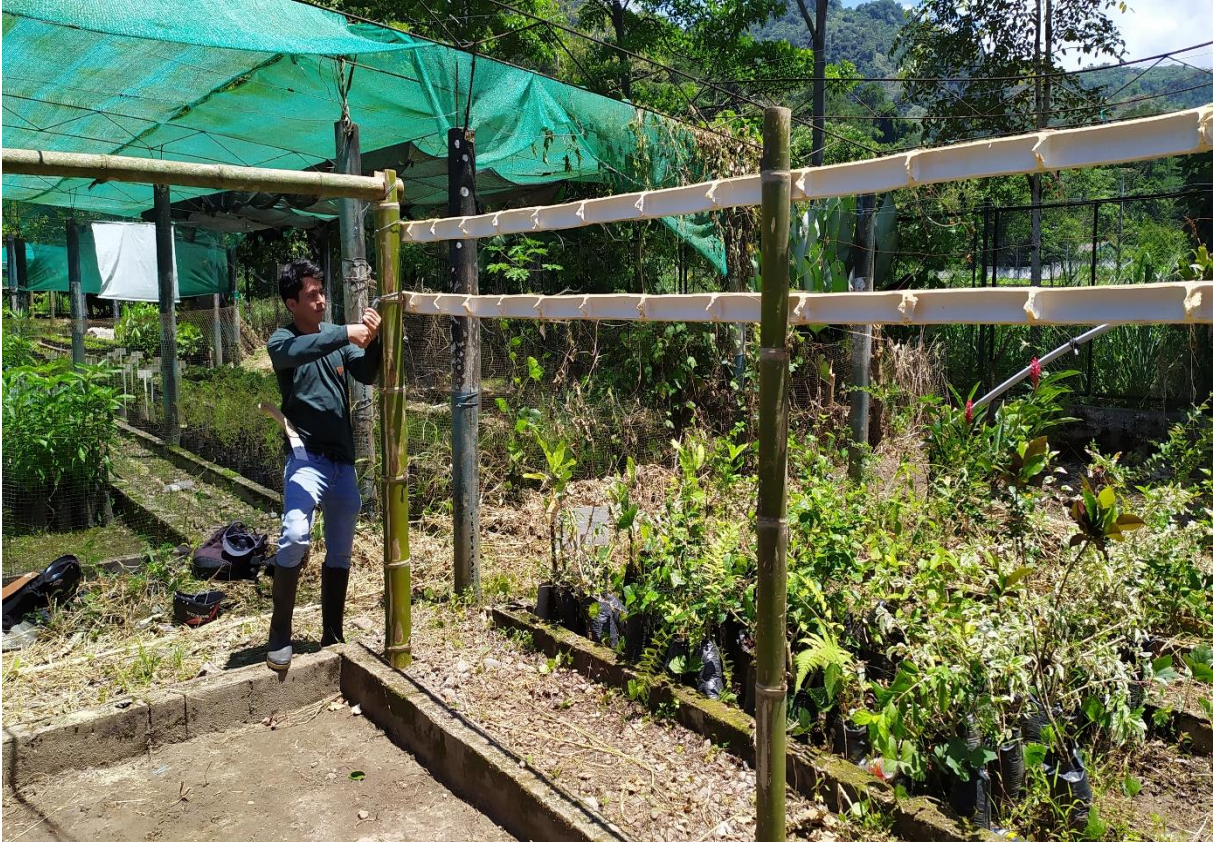
Figura 16. Construcción de la cámara térmica.
