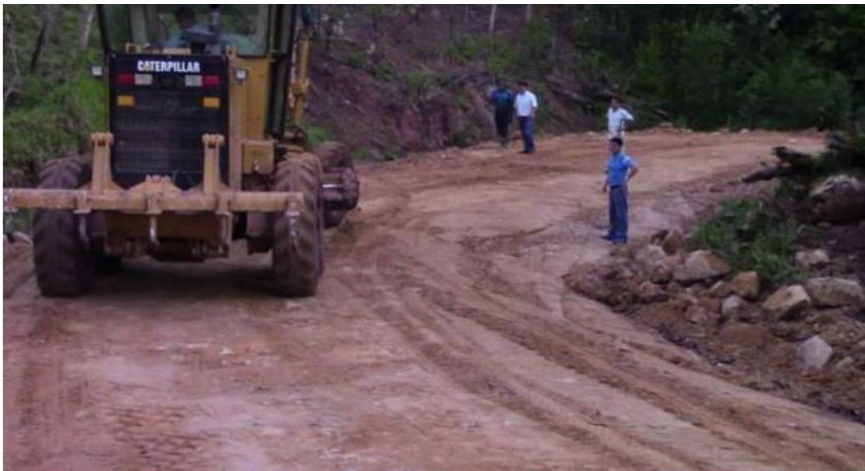
Figura 18. Mejoramiento de la trocha carrozable tramo Km45 –Challual, en el marco de la implementación de los planes de calidad de vida.
