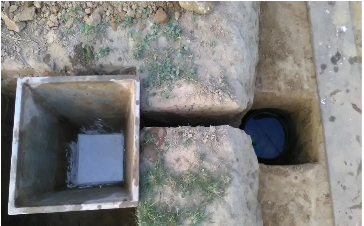
Figura 18. Prueba de circulación del agua al depósito de almacenamiento.
