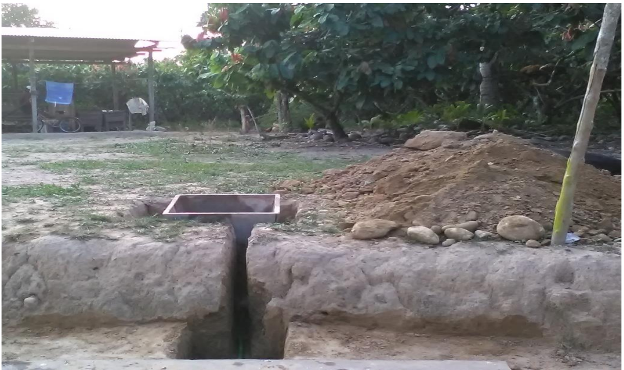
Figura 16. Colocación de maceta en la excavación realizada.
