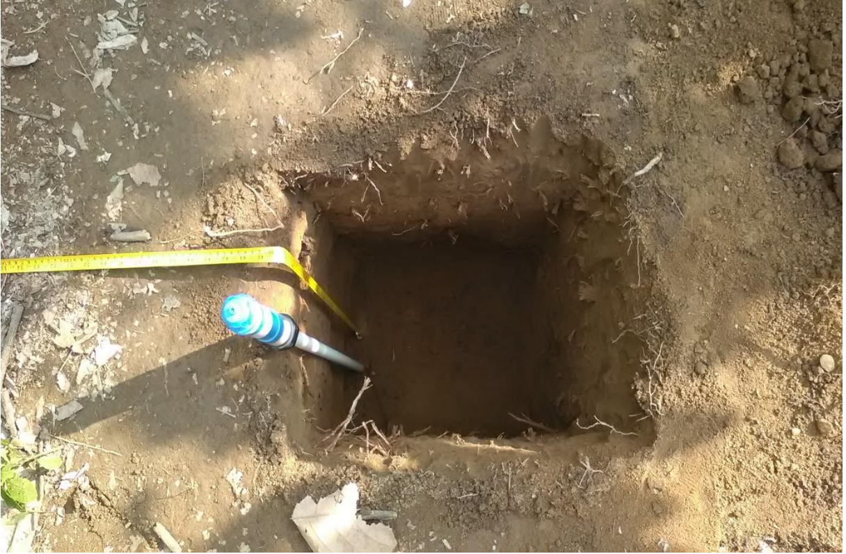
Figura 21. Calicata a profundidad de 1,00 m.
