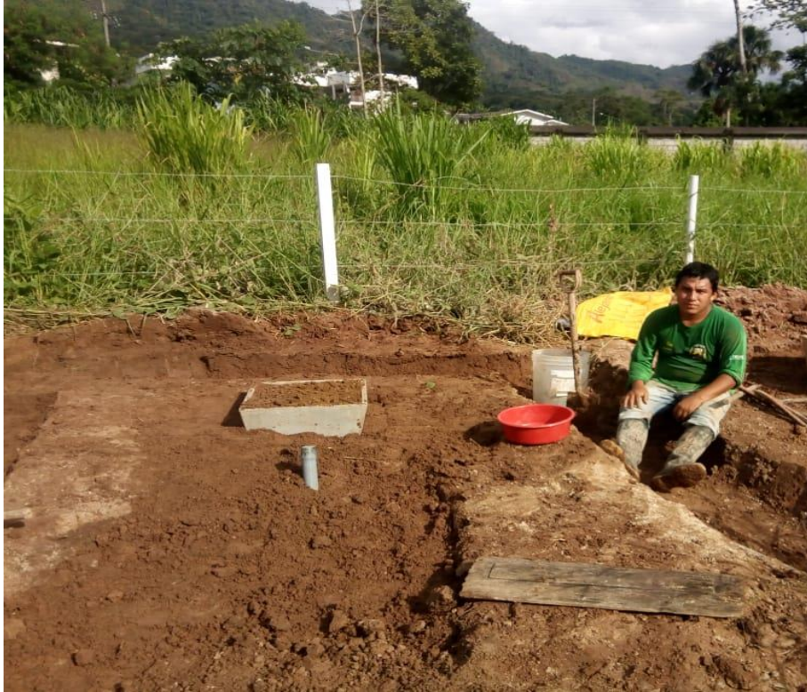
Figura 25. Instalación de los dos lisímetros de drenaje de succión.
