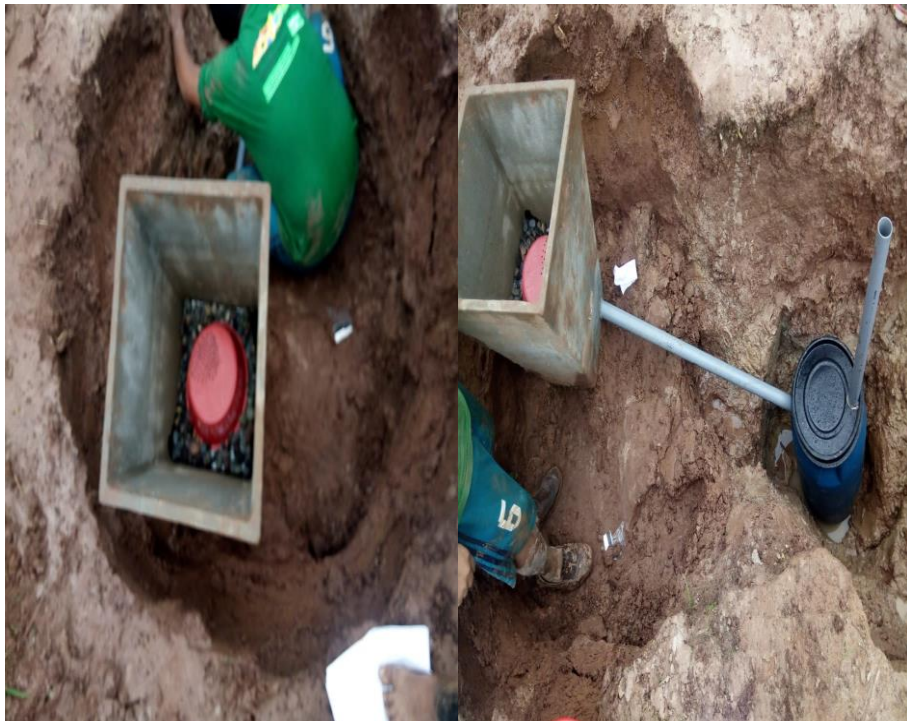
Figura 24. Excavación y presentación del lisímetro de drenaje de succión.
