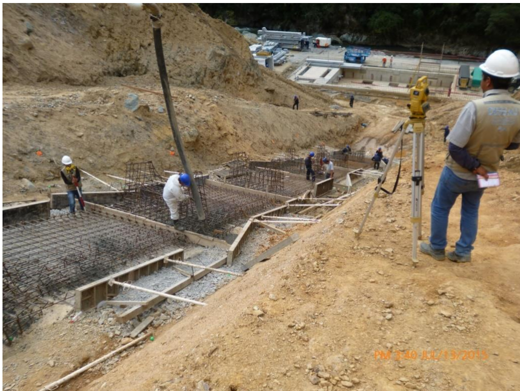
Figura 19. Verificaciones topográficas de solados (pañes intercalados) de tubería forzada; tramo 0+096,70 a 0+102,20, 0+107,70 a 0+132,20, 0+118,70 a 0+124,20; en C.H. El Carmen.
