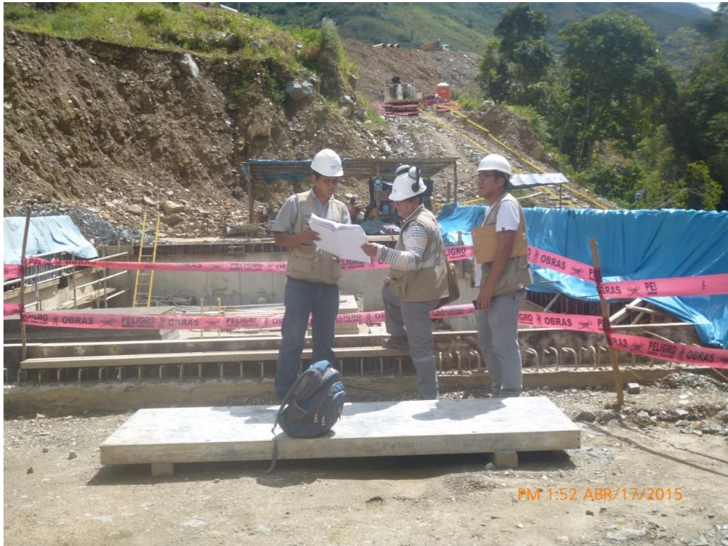
Figura 18. Trabajos en casa de máquinas de C.H. El Carmen.
