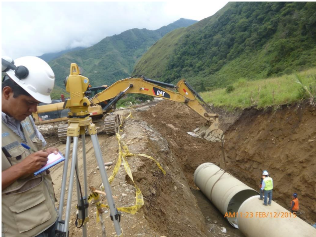
Figura 17. Instalación de tubo GRP 2+893 a 2+899 conducción de C.H. 8 de Agosto.
