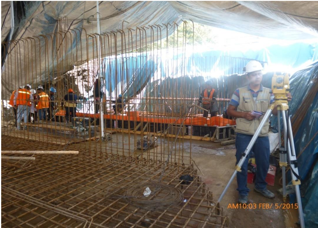
Figura 16. Cota de vértices y solado en casa de máquinas de C.H. El Carmen.
