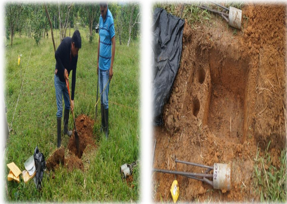
Figura 10. Construcción de la minicalicata para muestreo del suelo
