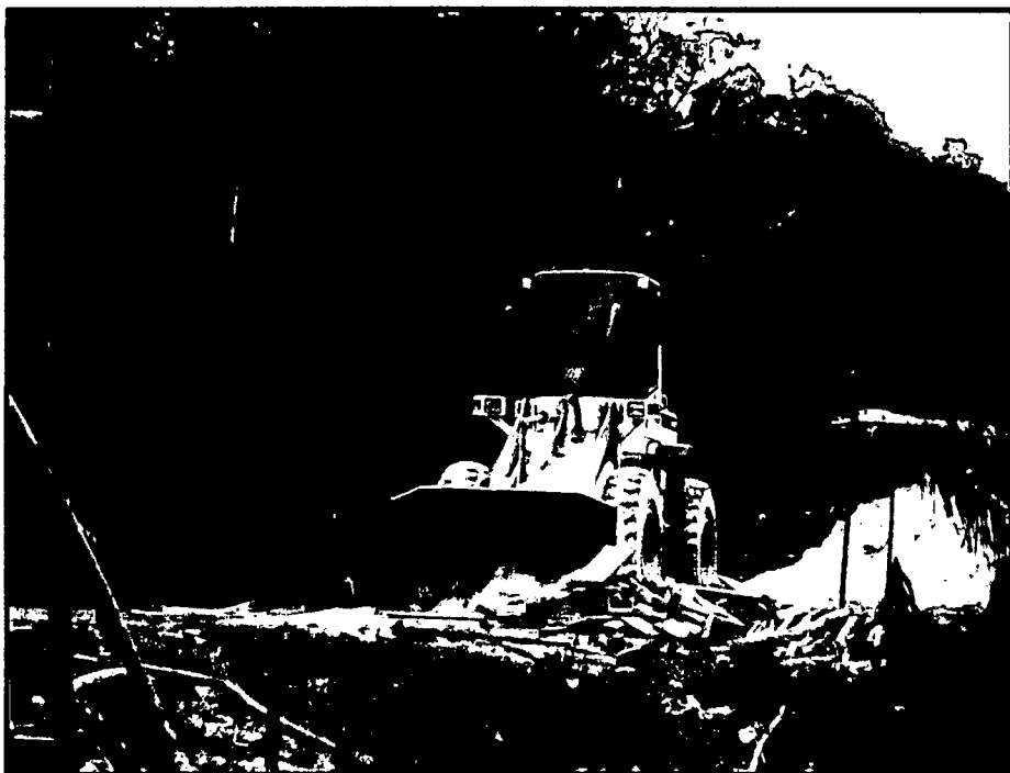
Figura 37. Tipo de maquinaria instalada en la zona
