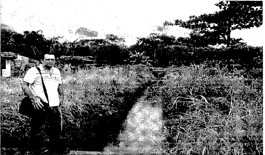
Figura 28. Falta de prácticas ambientales en el ámbito del canal pluvial Shiruy
