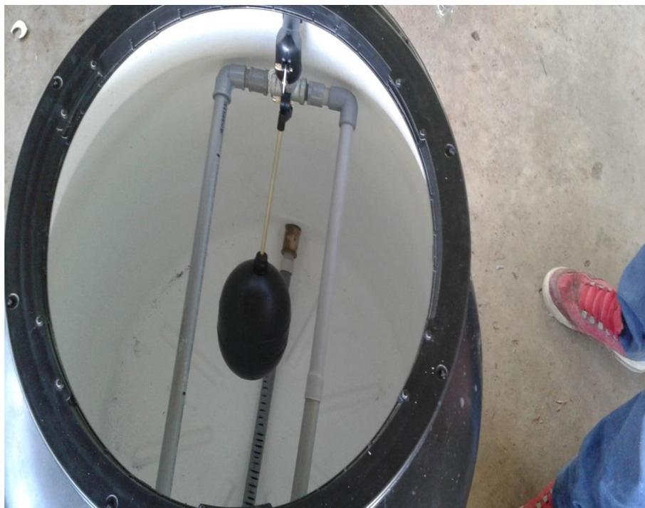
Foto 3: Vista interior de filtro. Tubo de distribución, boya para controlar el nivel y tubo de drenaje.
