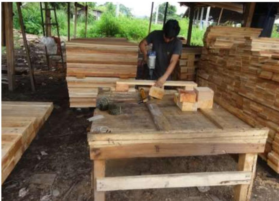
**Figura 11.** Armado de la base de las parihuelas.
