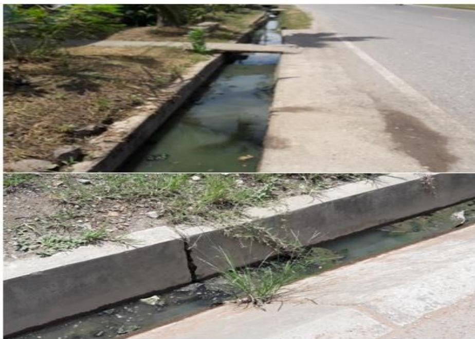
Figura 75. Cunetas empozadas y expuestas en los puntos 4 y 1
