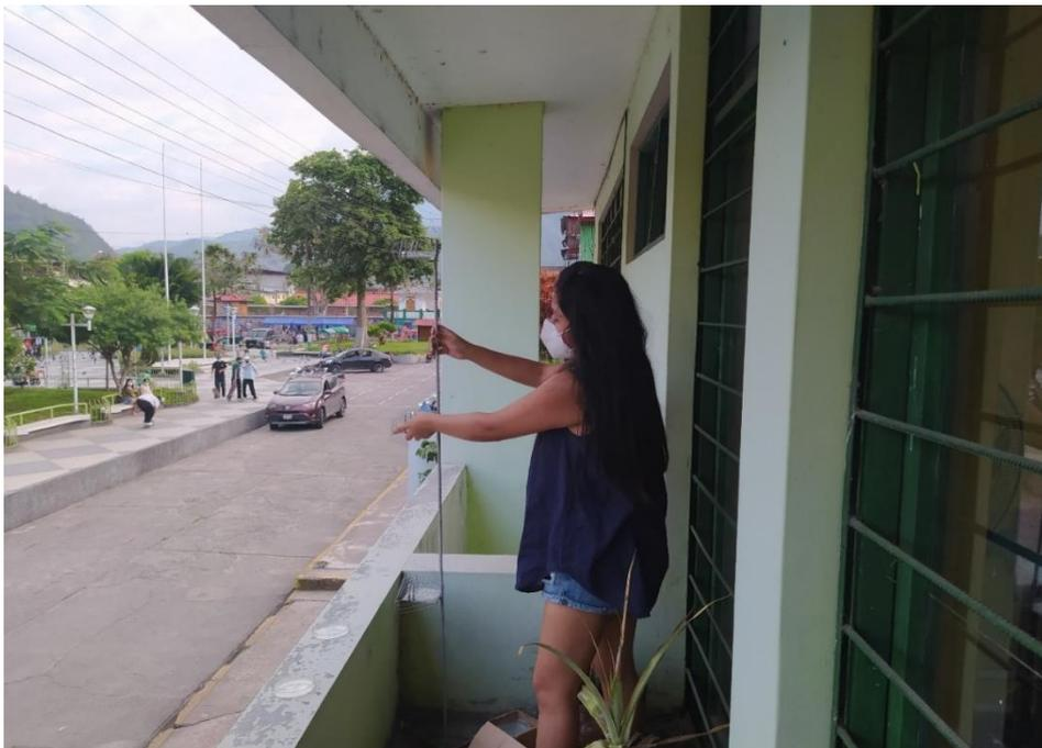
**Figura 24.** Instalación de estación de monitoreo de partículas atmosféricas sedimentables en el P-01.
