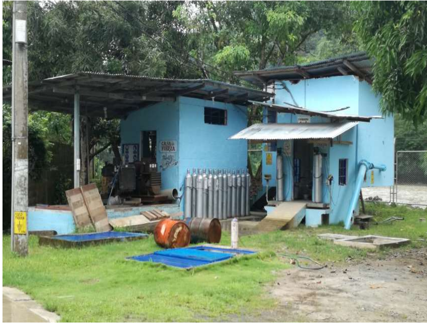
Figura 84. Instalaciones del proceso de cloración y la planta de producción del agua potable torre I.
