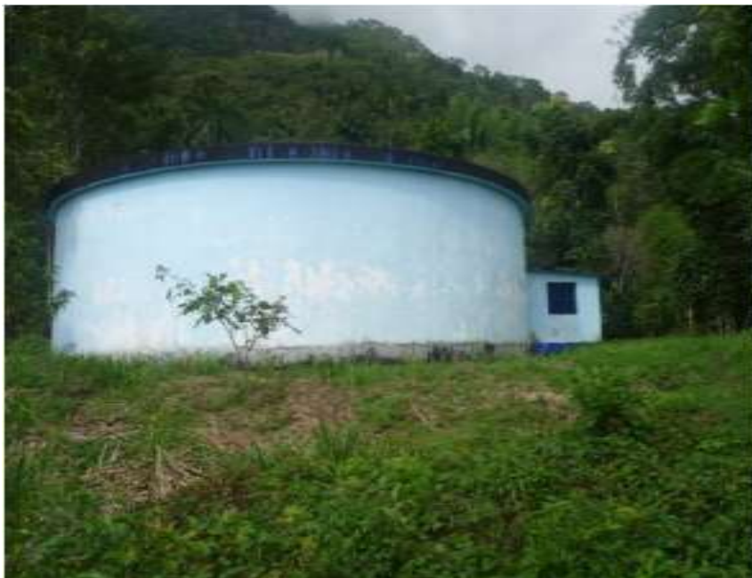
Figura 91. Reservorio de Castillo Grande de la zona Castillo Grande con una capacidad de 1000 \text{ m}^3 .
