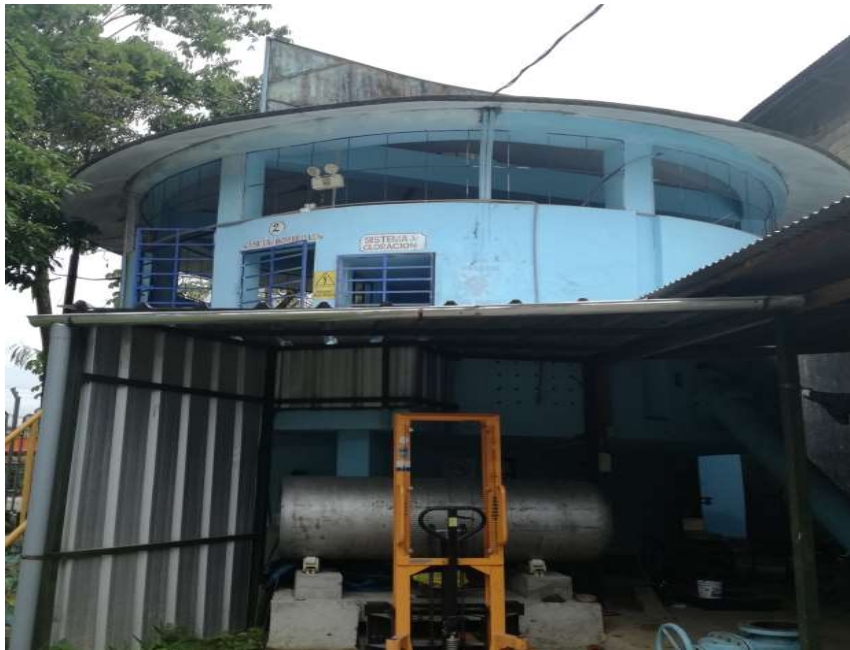
Figura 85. Instalaciones de la planta de producción del agua potable torre II
