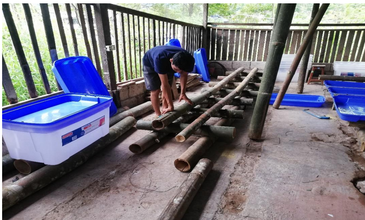
Figura 17. Construcción de los sistemas acuapónicos
