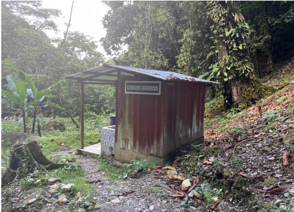
Figura 30. Instalación de módulos de servicio
