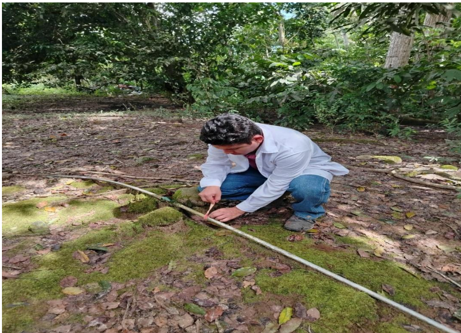
Figura 34. Medición de tubería de conexión domiciliar.
