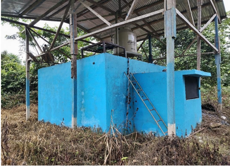
Figura 19. Reservorio del sistema de abastecimiento de agua potable.
