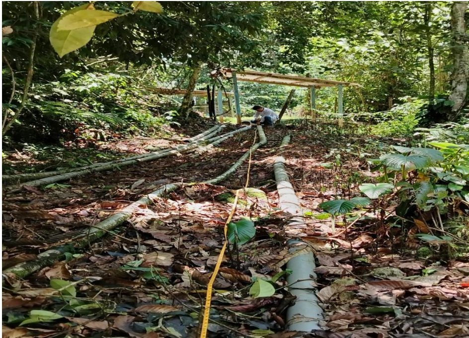
Figura 46. Medición de tubería del sistema de abastecimiento de agua potable.
