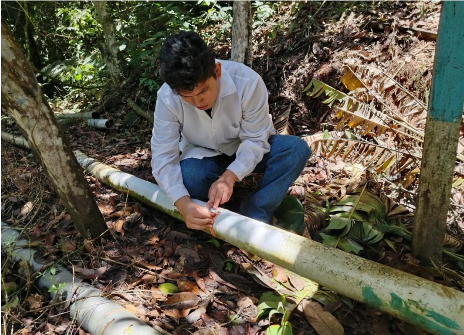
Figura 47. Medición de tubería del sistema de abastecimiento de agua potable.
