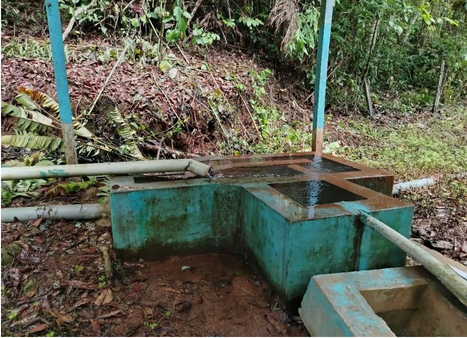
Figura 17. Desarenador del sistema de abastecimiento de agua potable.
