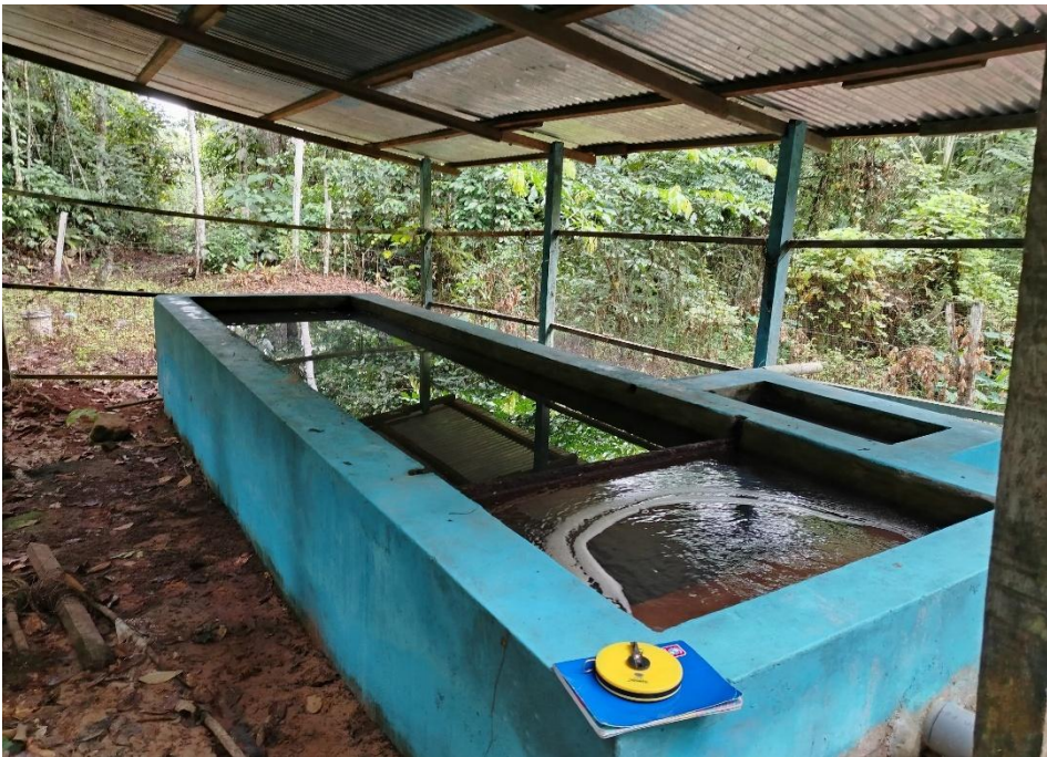
Figura 18. Sedimentador del sistema de abastecimiento de agua potable.
