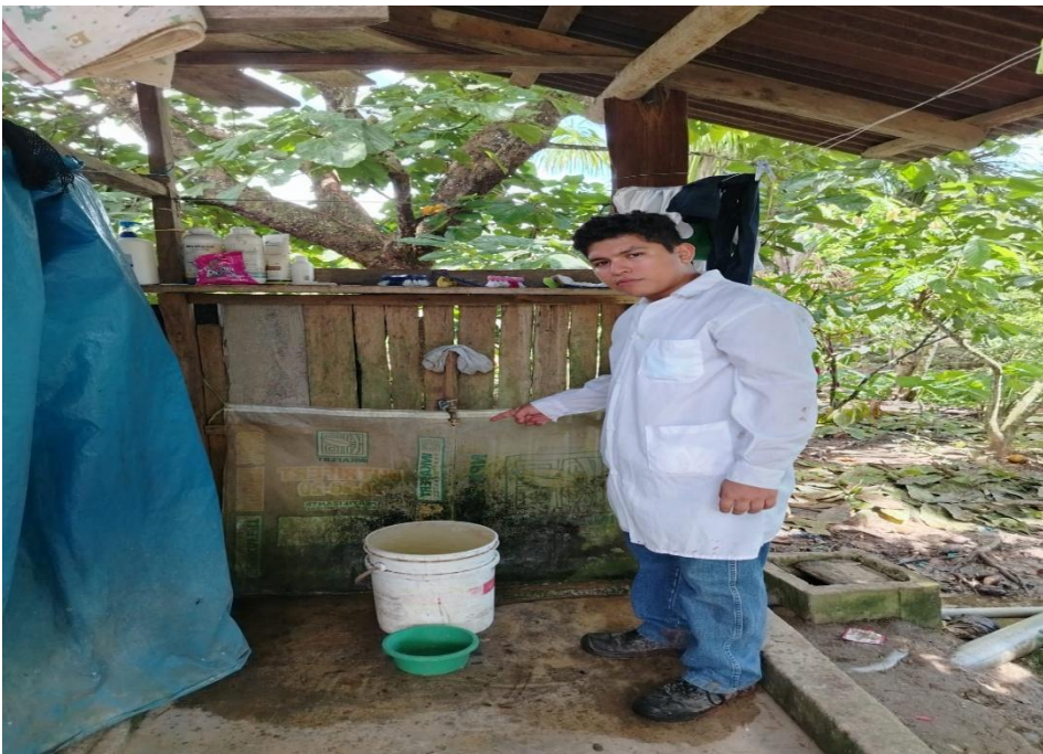
Figura 40. Conexión domiciliaria del sistema de abastecimiento de agua potable.
