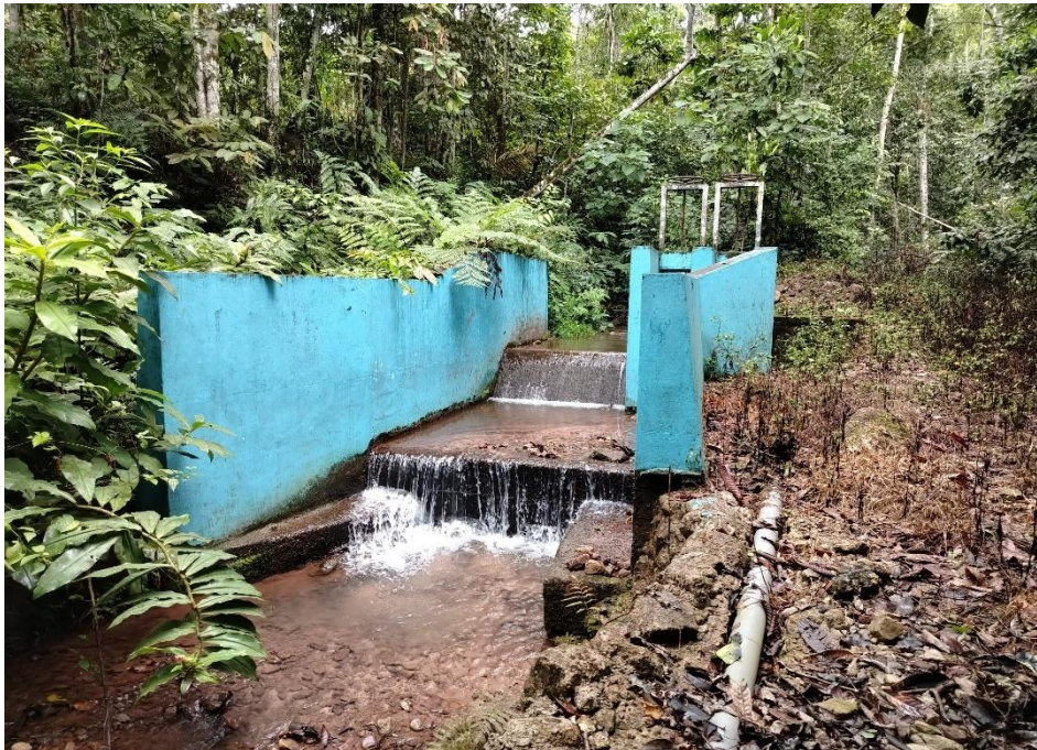
Figura 16. Captación del sistema de abastecimiento de agua potable.
