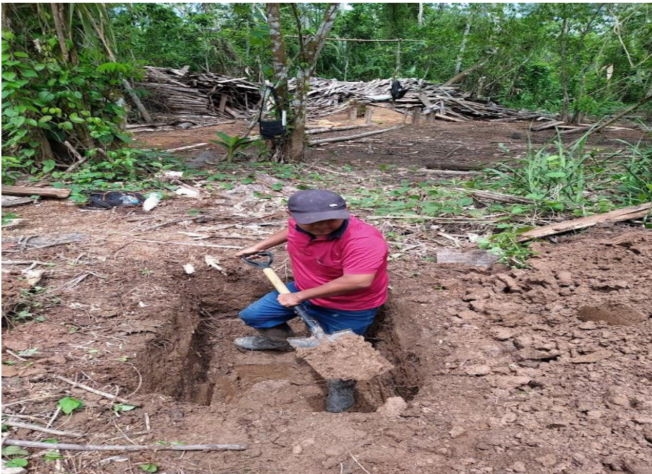
Figura 15. Apertura del hoyo de la calicata 4
