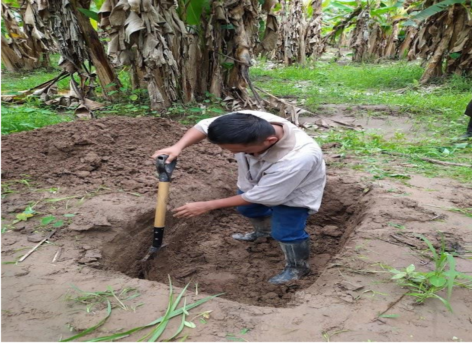
Figura 14. Apertura del hoyo de la calicata 3
