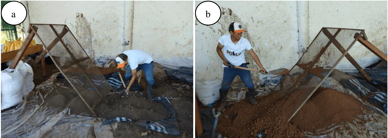
Figura 25. Preparación de los sustratos: a y b. Tamizado de los diferentes sustratos.
