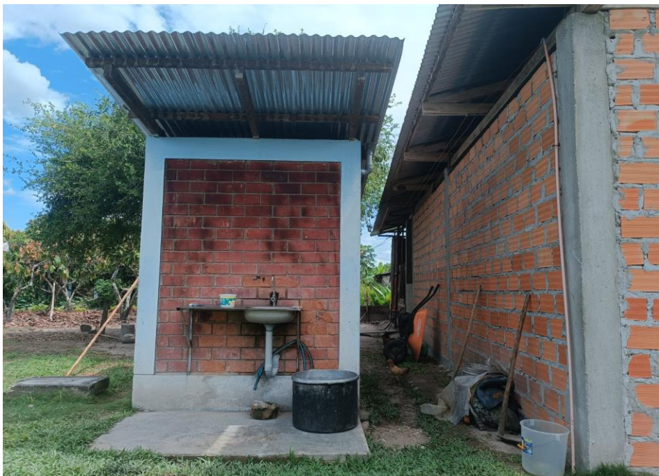
Figura 49. Lavaderos externos para las tomas de agua en el centro poblado de Shepte
