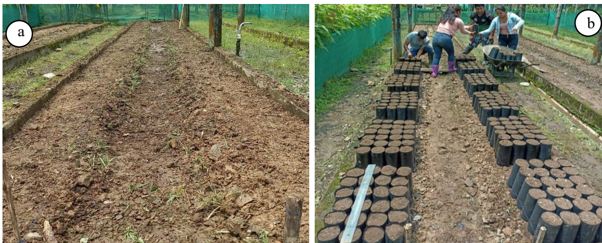
Figura 9. Área de la tesis: a. Limpieza y b. Acondicionamiento
