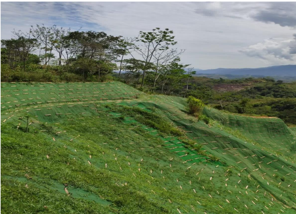
Figura 15. Área de deslizamiento en recuperación protegida con geo mallas y pasto.
