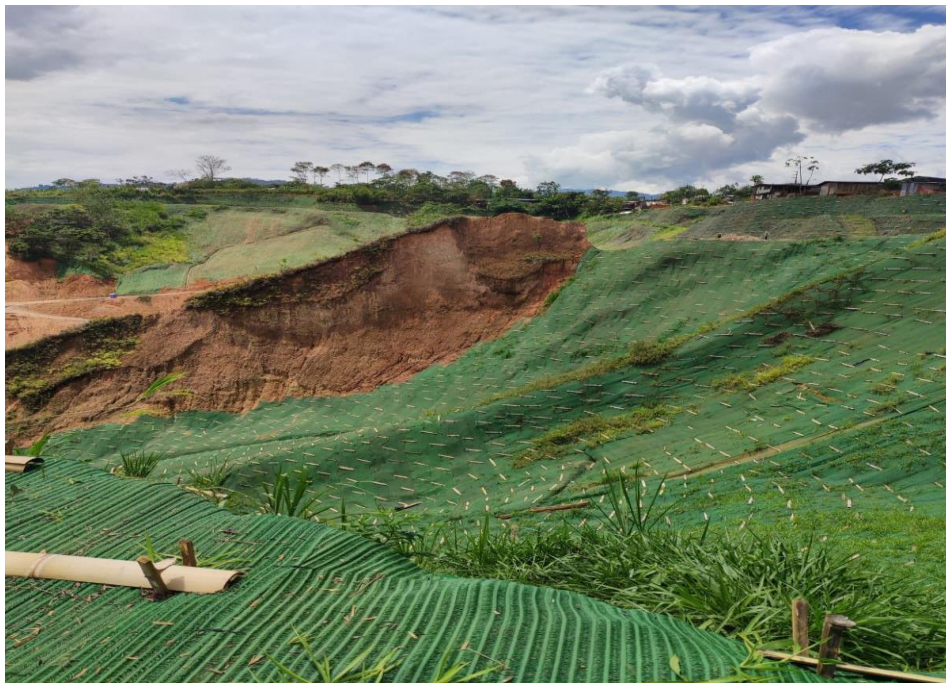
Figura 13. Implementación de geo mallas de protección en el deslizamiento del caserío de “Las Vegas”.
