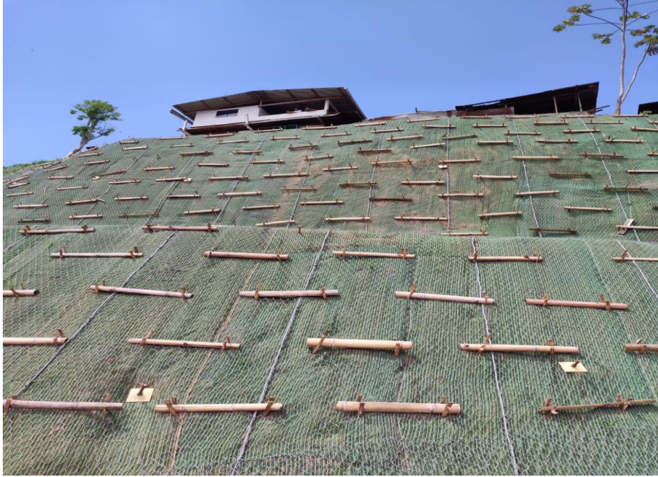
Figura 14. Implementación de mallas metálicas para evitar futuros deslizamientos de tierra.
