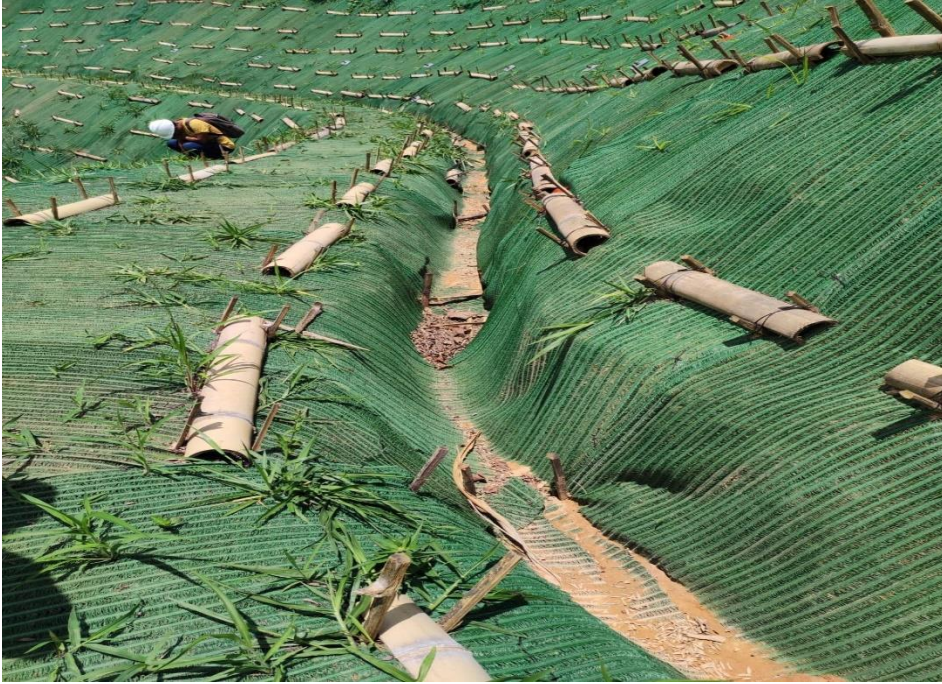
Figura 16. Drenaje de coronación en las geo mallas.
