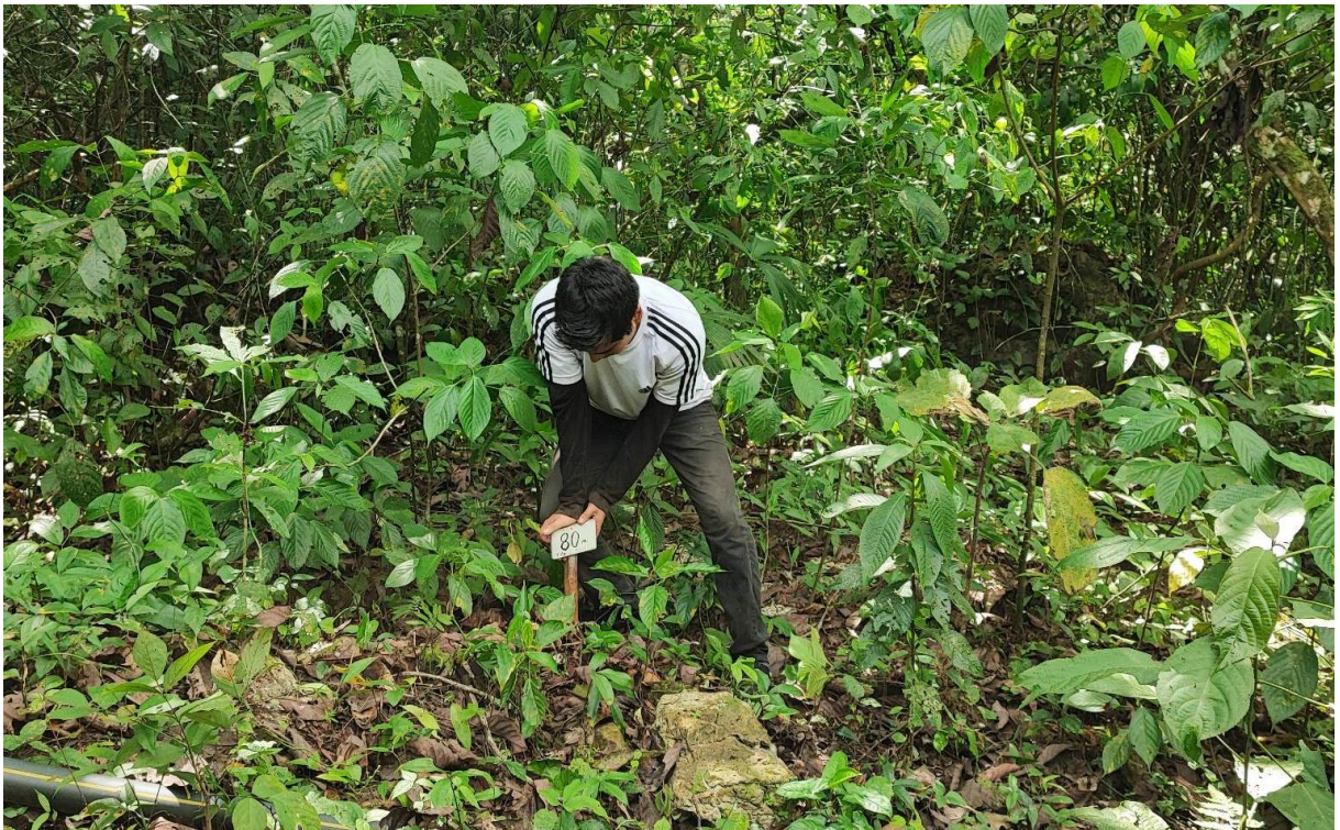
Figura 18. Instalación de estacas cada 40 metros en el sector Quinceañera.
