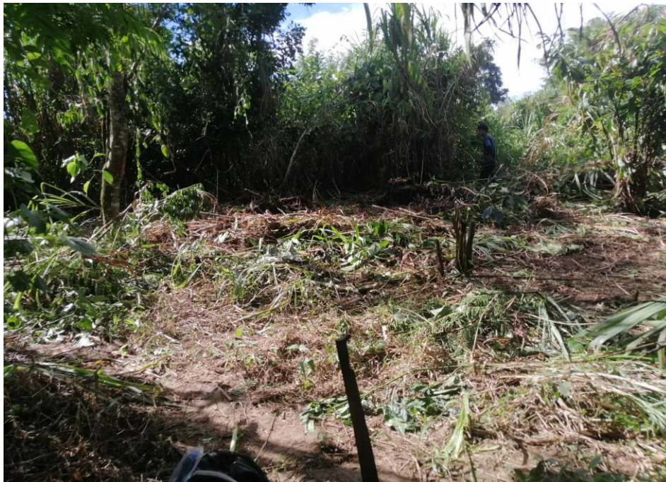
Figura 15. Limpieza del terreno
