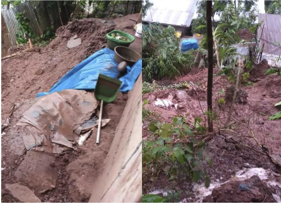
Figura 31. Deslizamiento en la Asociación Habitacional Sven Ericsson, Sector II -Tingo María ocurrido en la fecha 09/01/2020. Tomado por Zona Tingaleza.
