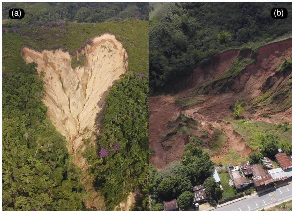
Figura 36. Eventos de deslizamientos. (a) Huayco en la localidad San Cristobal ocurrido en la fecha de 02/01/2020 y (b) Deslizamiento en localidad Antonio Raimondi – Las Vegas ocurrido en la fecha 06/02/2020.
