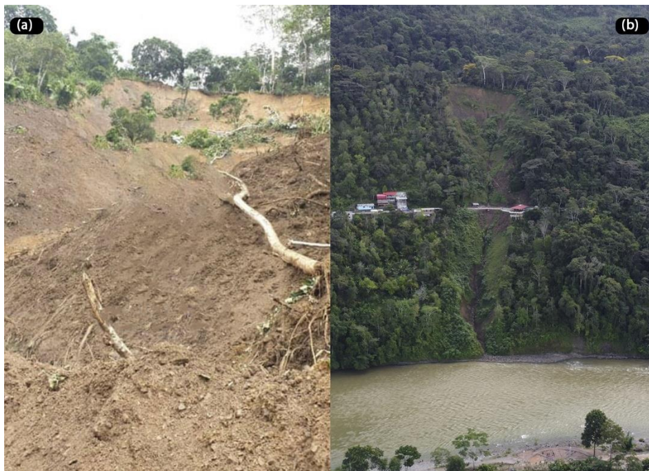
Figura 34. Deslizamiento en Jacintillo en el tramo Corpac – Bella Alta ( km 5+050)- Castillo Grande, ocurrido en la fecha 01/12/2020. (a) Vista en el momento de la ocurrencia, tomado por Zona Tingaleza y (b) Vista aérea en el año 2021.
