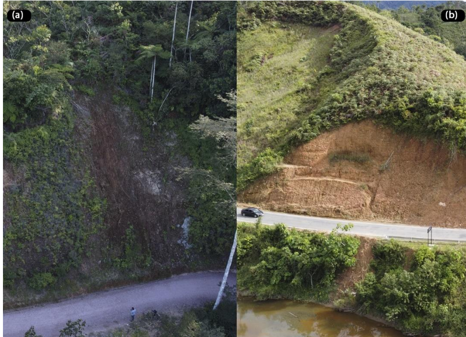
Figura 29. Eventos de deslizamientos. (a) Tramo Bella Alta – Rio Tigre ocurrido en la fecha 01/1/2020 y (b) Tramo Tingo María – Monzón (caserio Inti) ocurrido en la fecha de 1/12/2020.
