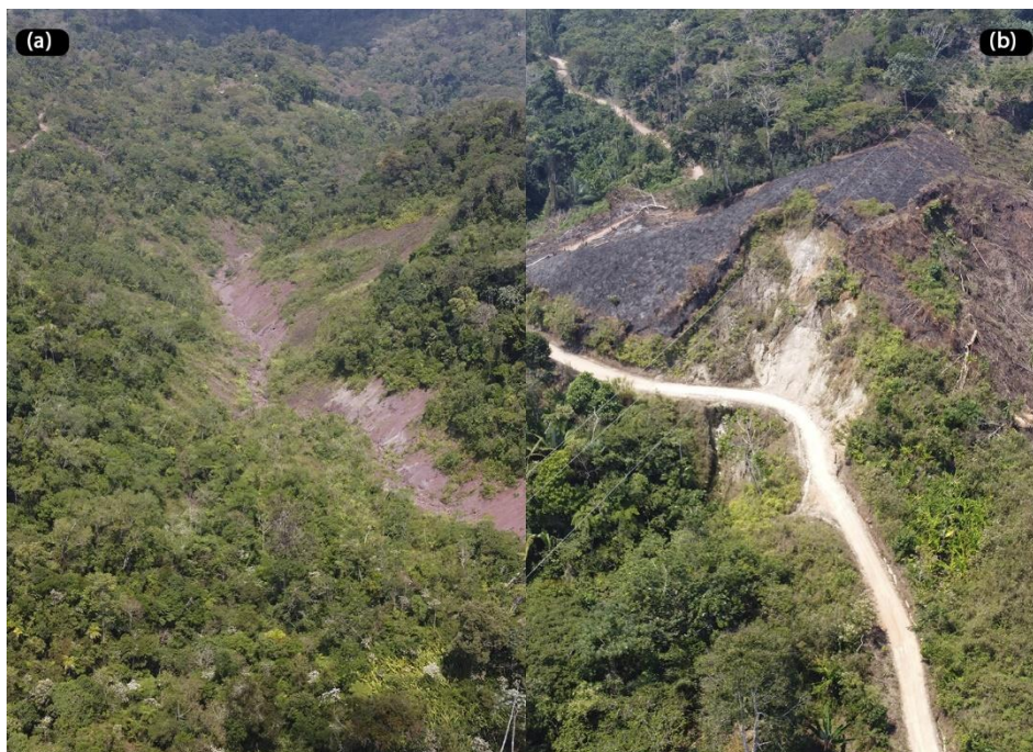
Figura 42. Eventos de deslizamientos. (a) Deslizamiento en localidad de San Agustín ocurrido en la fecha de 22/03/2010 y (b) Huayco en el tramo Shangai – 3 de Octubre ocurrido en la fecha 05/04/2019.
