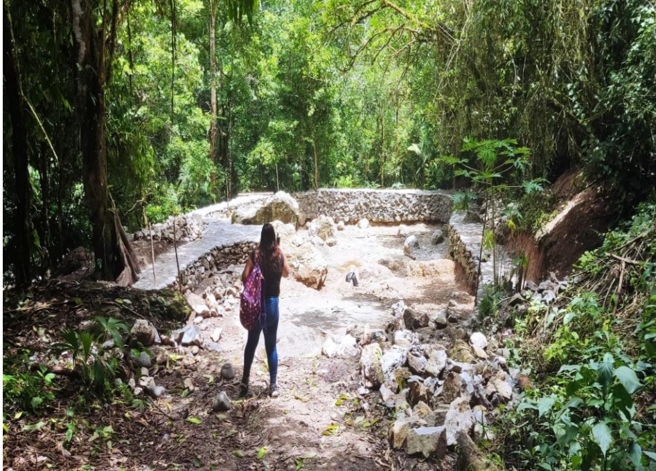
Figura 22. Piscina en construcción de la catarata Honolulu
