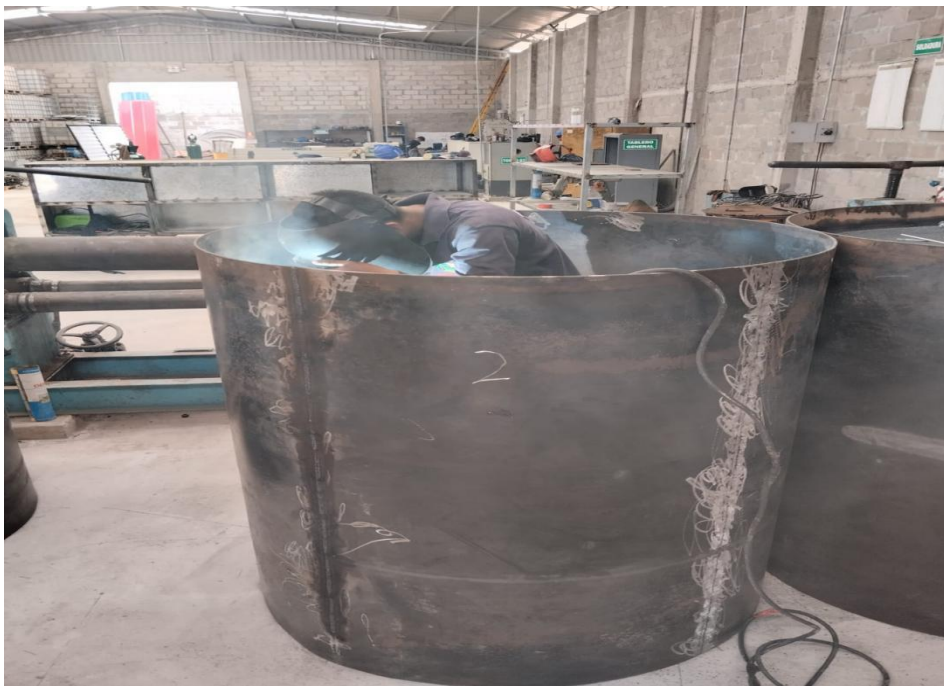
Figura 35. Cuerpo de la torre de lavador siendo armado.
