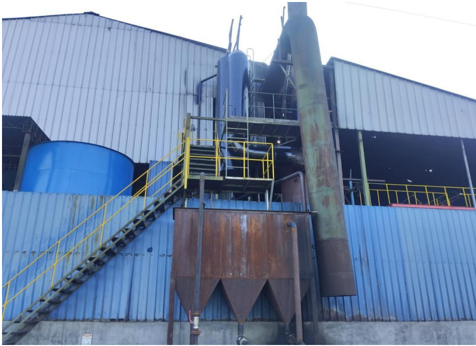
Figura 40. Instalación completa de la torre de lavado y pintado de la torre de lavado de color negro de alta Resistencia de temperatura.
