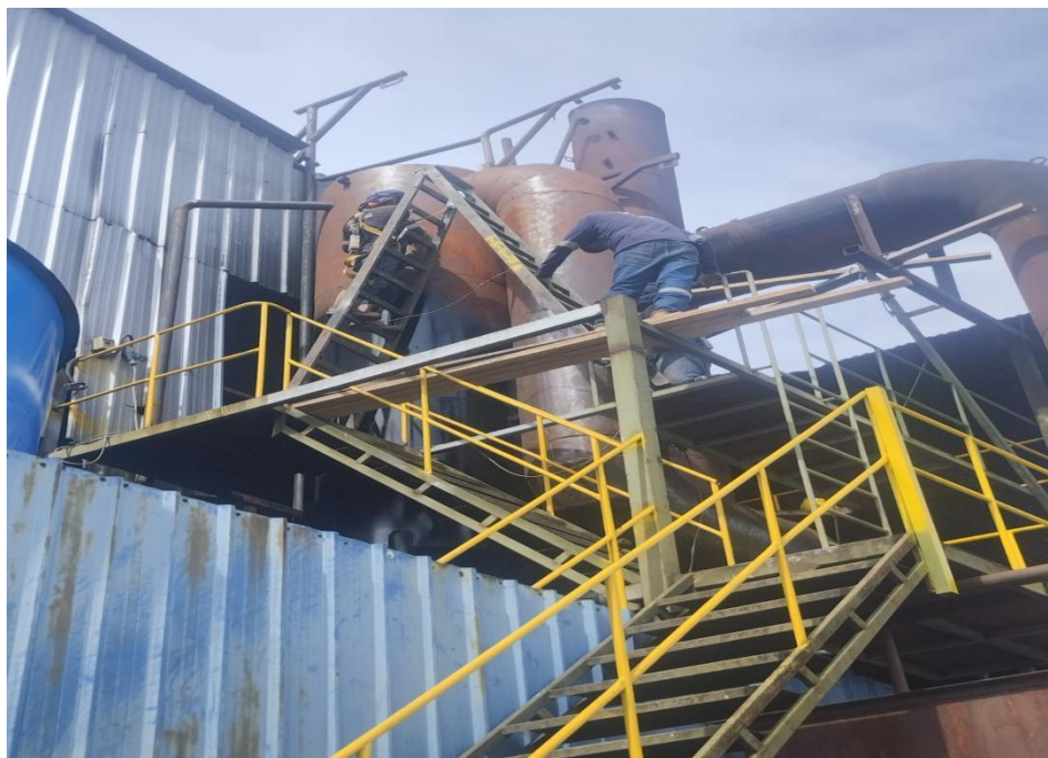
Figura 39. Instalación de los ductos de la torre de lavado y el florentino de recuperación de las aguas residuales.
