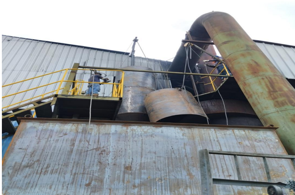
Figura 38. Instalación del 3er cuerpo de la torre de lavado realizada por el área de mantenimiento.
