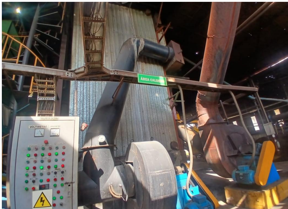
Figura 32. Punto de inicio de humo o gases en área de caldero.
