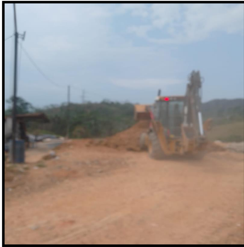
Figura 13. Movilizando tierra para el tapado de la celda
