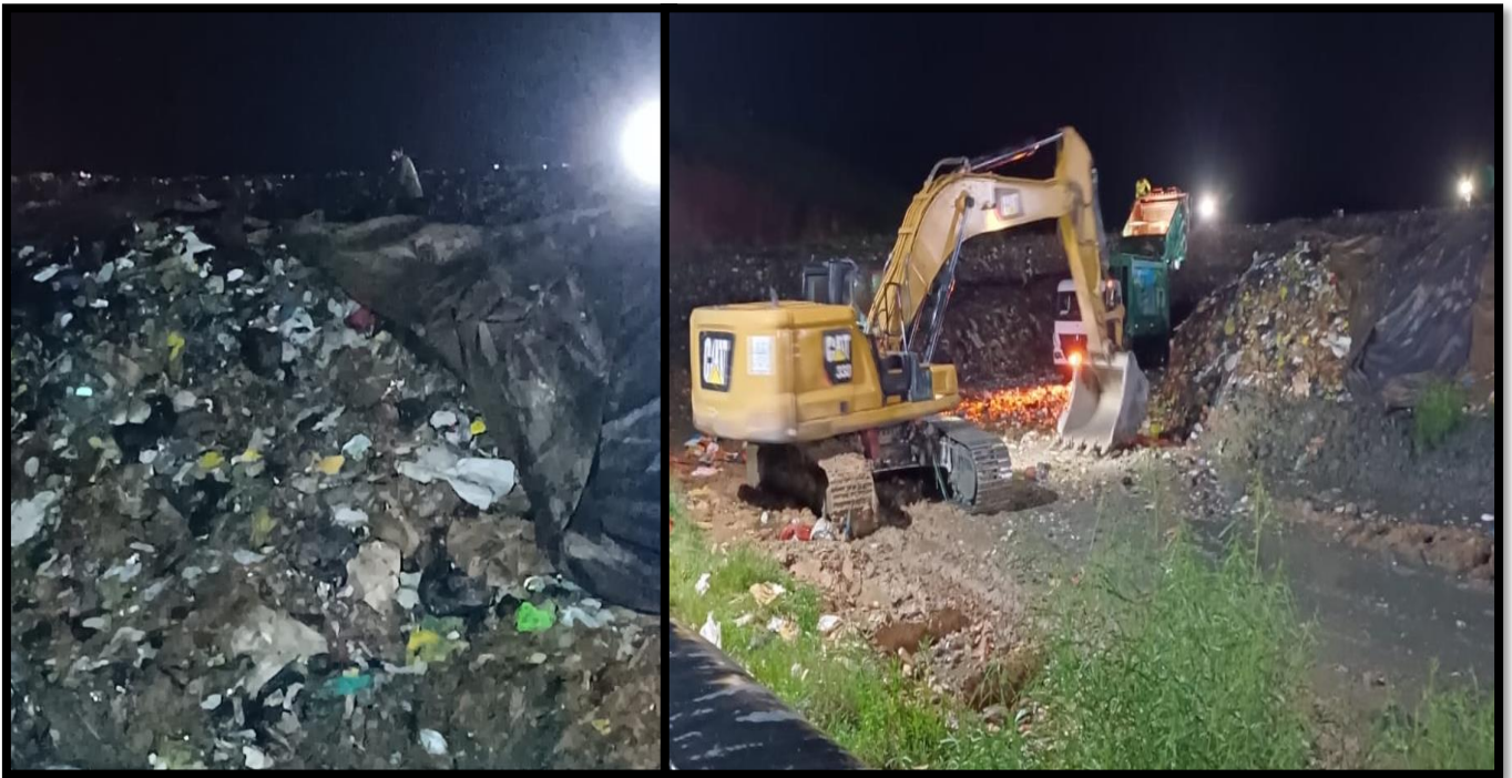
Figura 11. Destapando la celda para disposición de residuos
