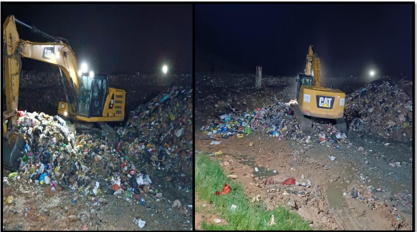
Figura 12. Uso de maquinaria para acomodar los residuos en la celda.
