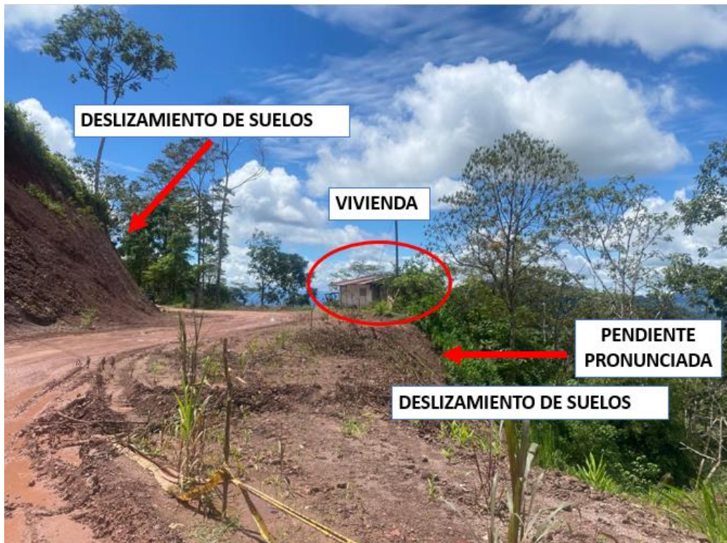
Figura 21. Vivienda 1 expuesto a deslizamiento de suelos.
