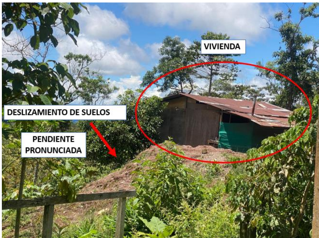
Figura 22. Vivienda 2 expuesto a deslizamiento de suelos.
