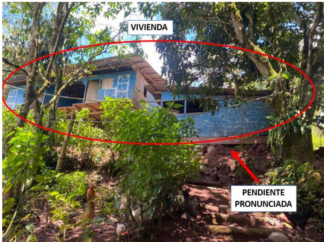
Figura 23. Vivienda 4 expuesto a deslizamiento de suelos.
