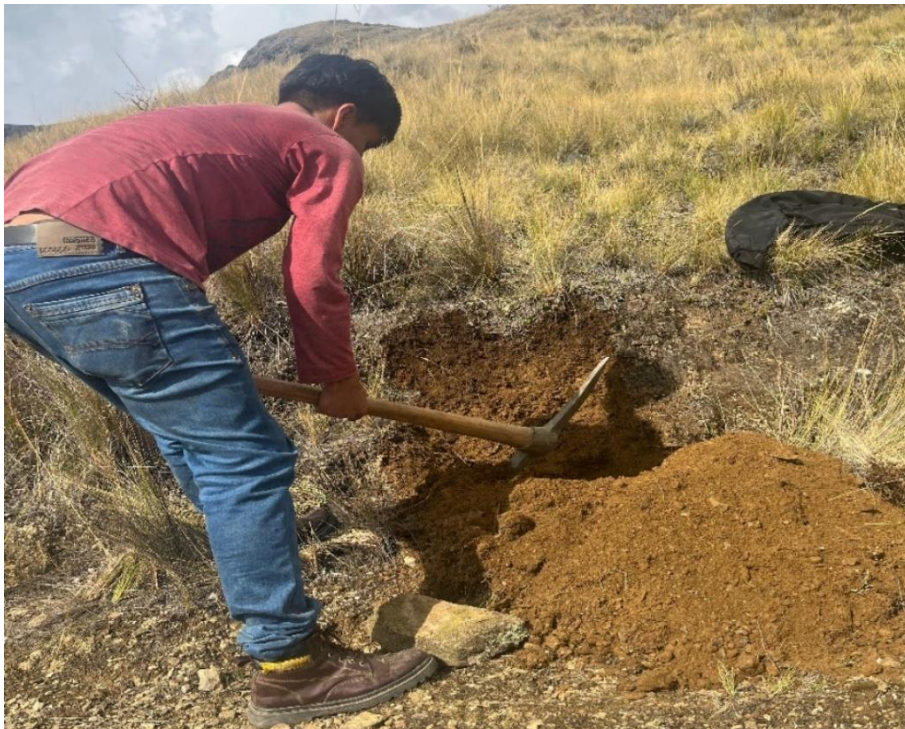
Figura 6. Realizando la excavación para la calicata
