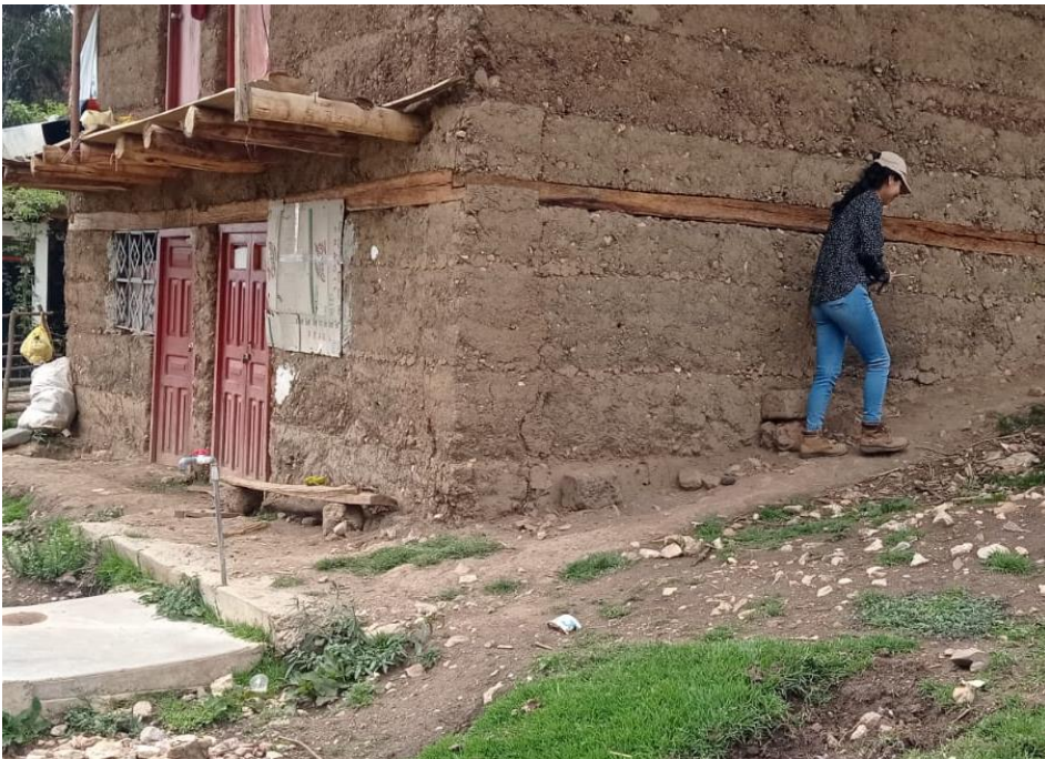
Figura 23. Identificación de las tomas domiciliarias.
