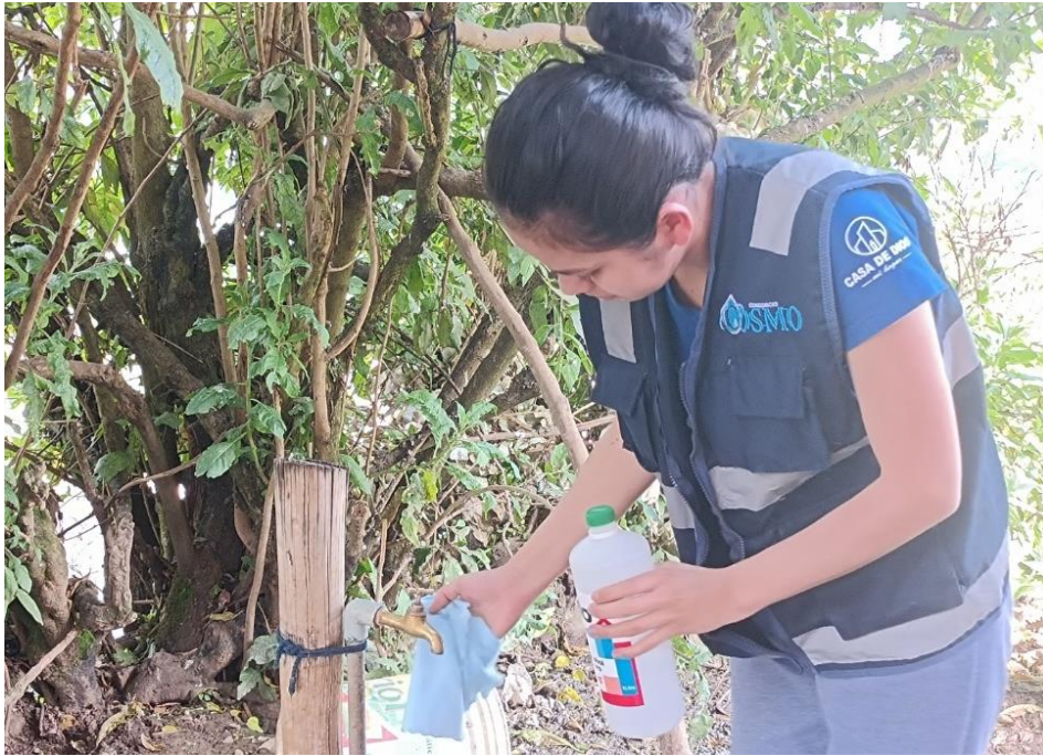
Figura 32. Desinfección de las tomas domiciliarias
