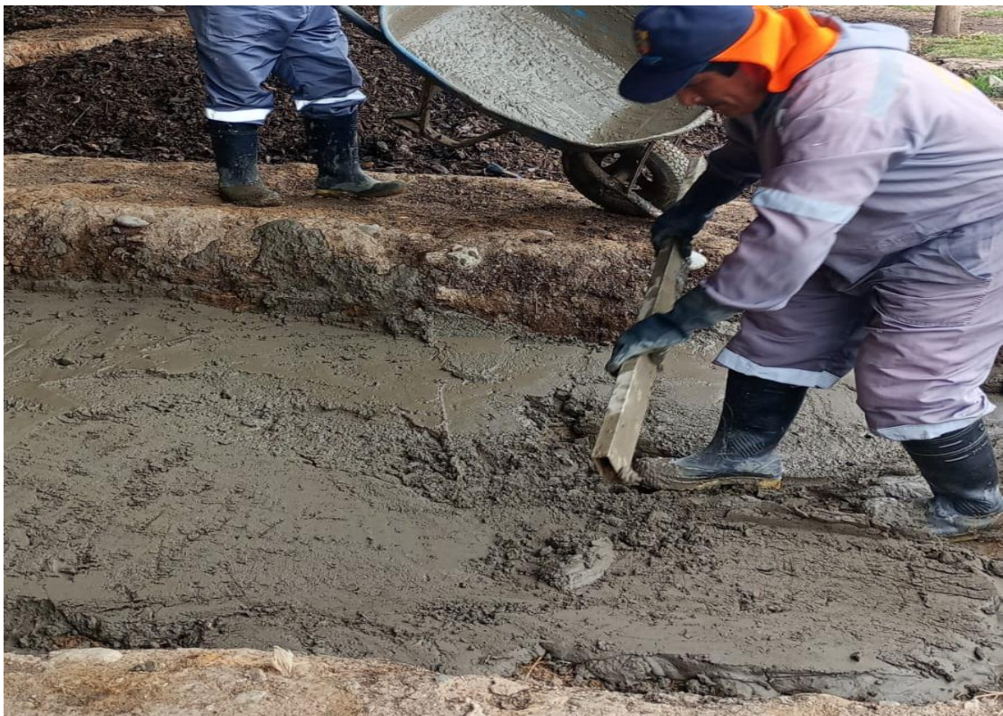
Figura 37. Acondicionamiento de la base para la formación de las pilas.
