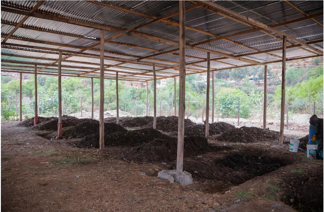
Figura 36. Planta de valorización de residuos sólidos orgánicos de la municipalidad distrital de Pillco Marca
