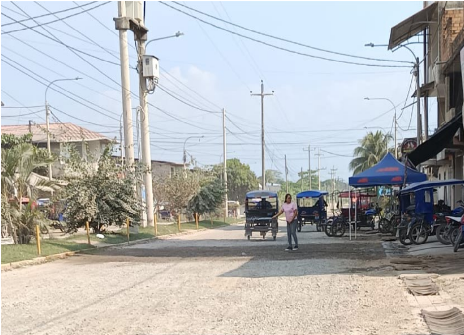
Figura 20. Riego en calle sin pavimentar
