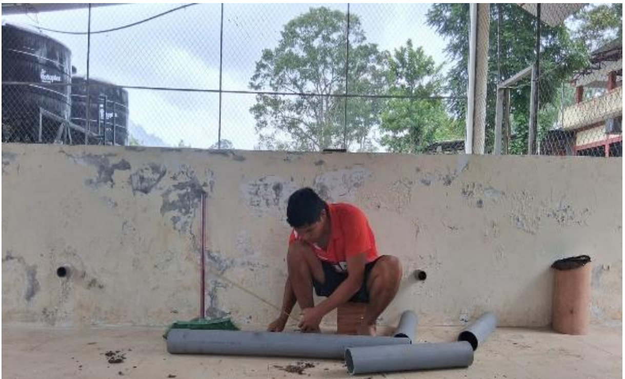
Figura 8. Instalación de las tuberías en los estanques.
