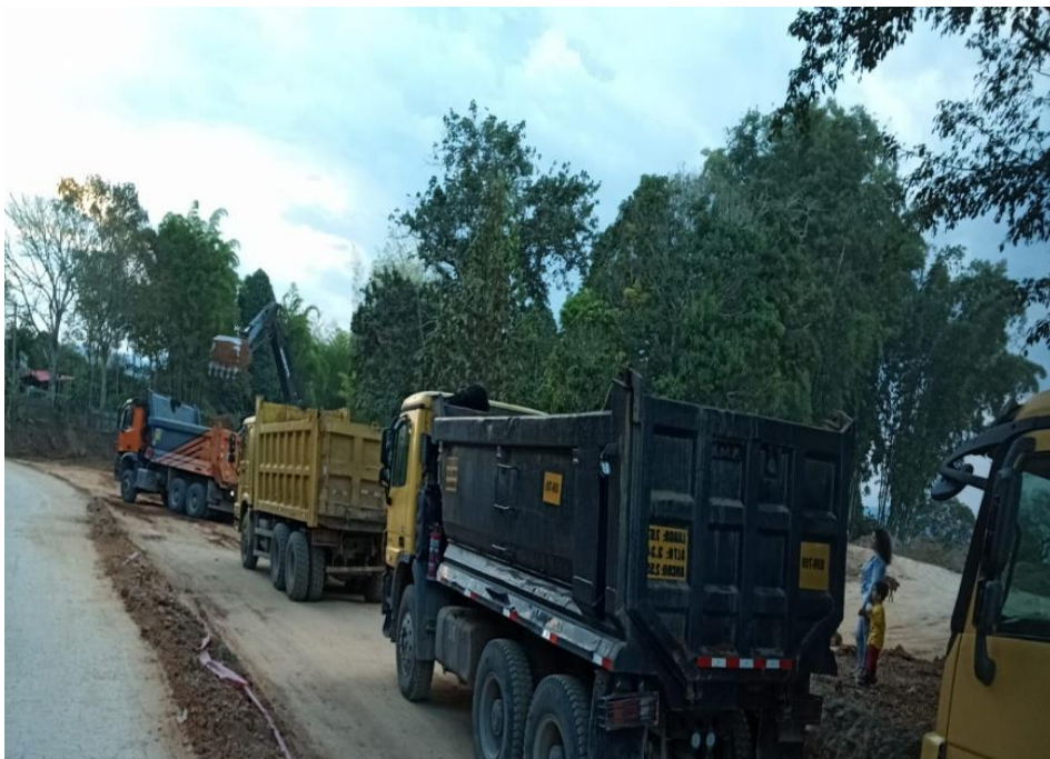
Figura 19. Carguío del material a los volquetes al DME 2
