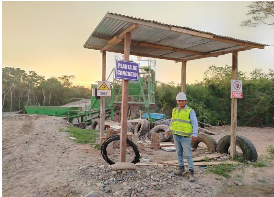
Figura 9. Planta de concreto
