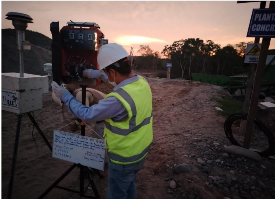
Figura 16. Instalación del tren de muestreo para la medición del gas CO en la planta de concreto
