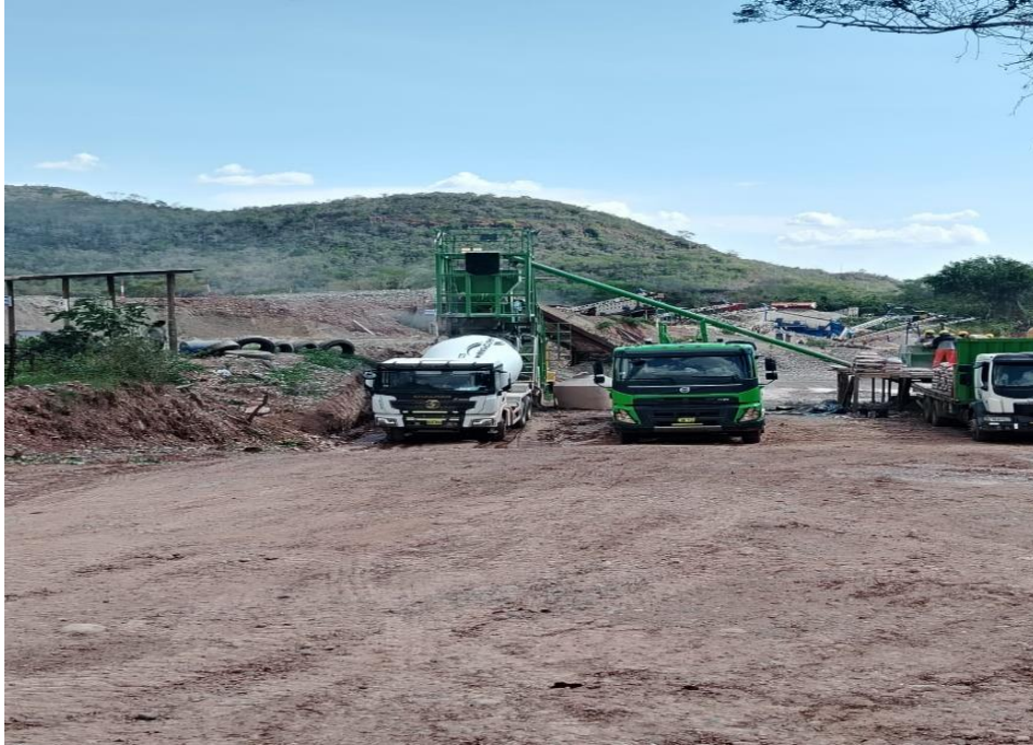
Figura 12. Abastecimiento de cemento para el procedimiento de mezcla en los mixers
