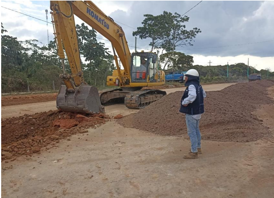
Figura 18. Extracción de material por la excavadora del DME 2
