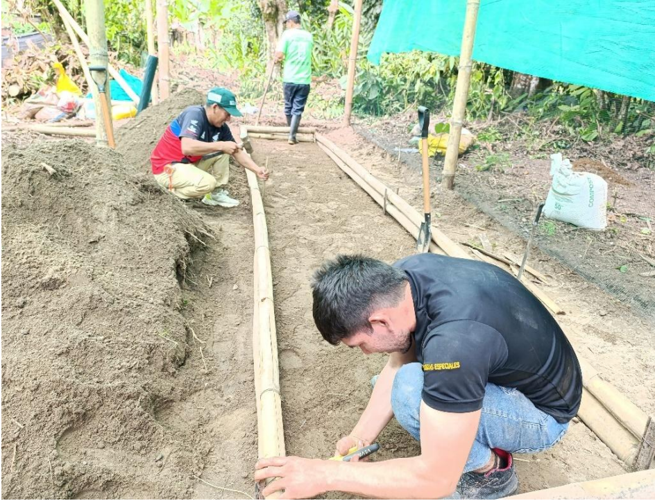
Figura 43. Construcción del vivero y camas para germinación y cría de plántones.
