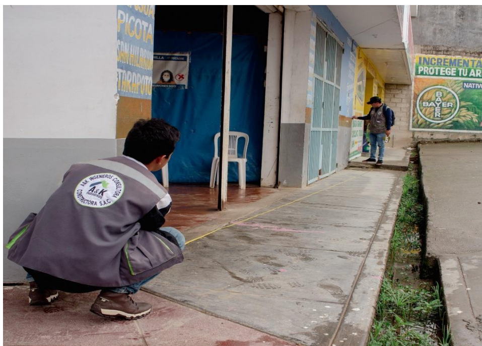
Figura 27. Medición con wincha de las viviendas construidas
