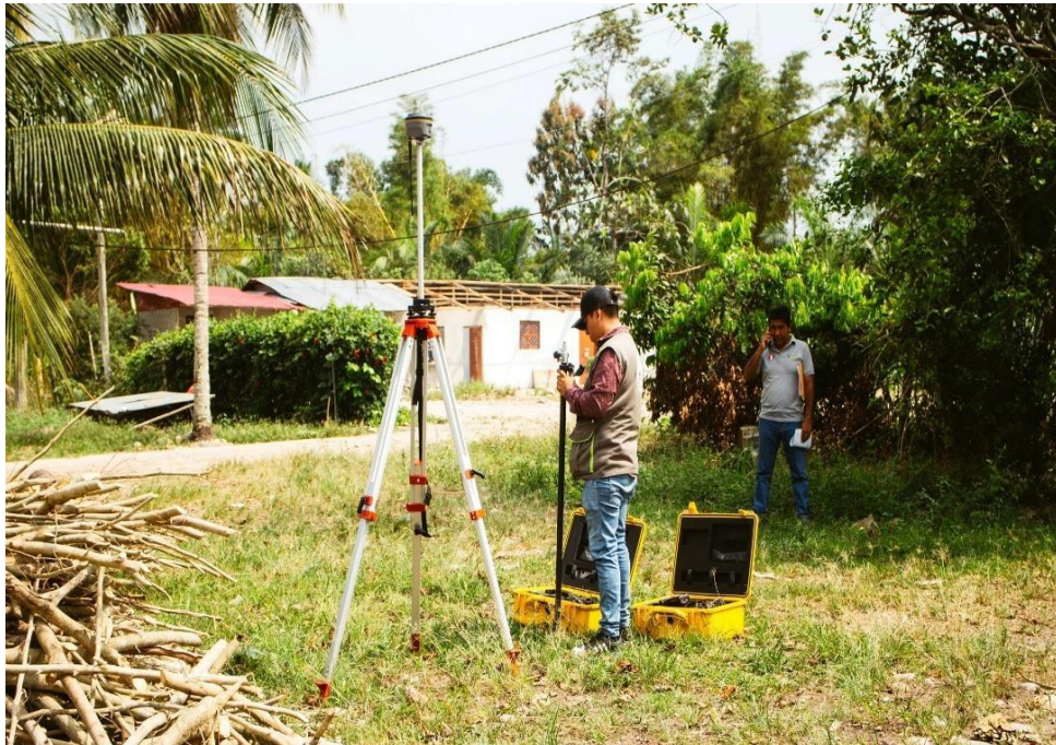
Figura 24. Conexión del Rover con la Base mediante el colector
