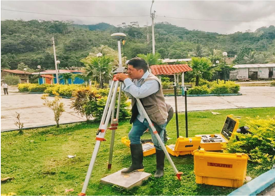
Figura 23. Ubicación e instalación del punto geodésico
