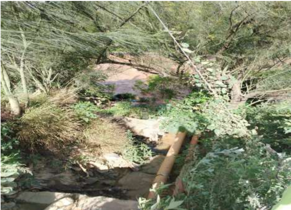
Figura 94. Punto de vertimiento.
