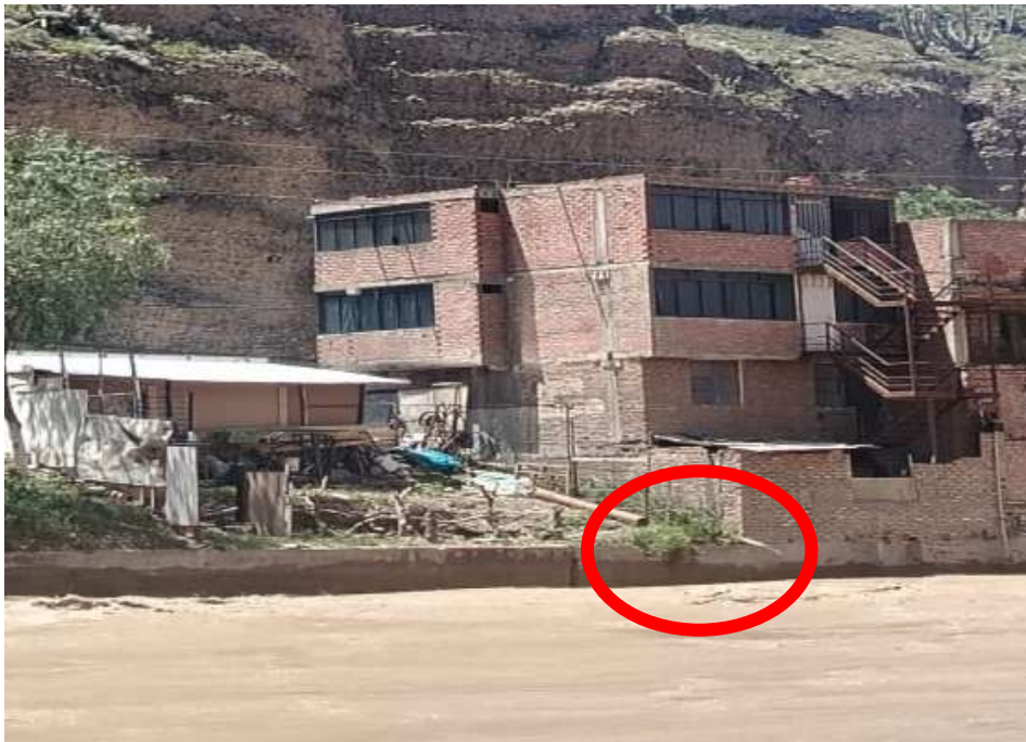
Figura 90. Punto de vertimiento.
