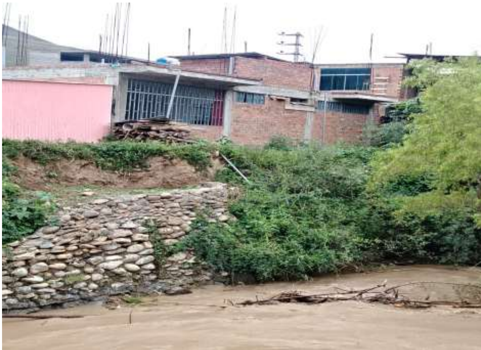
Figura 87. Punto de vertimiento.
