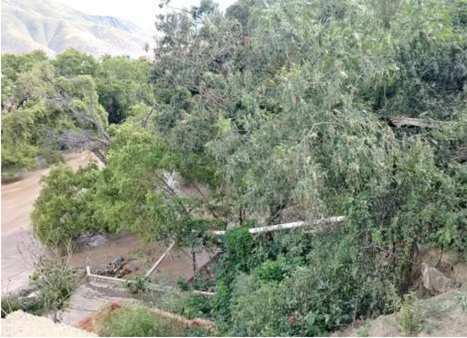
Figura 93. Punto de vertimiento.
