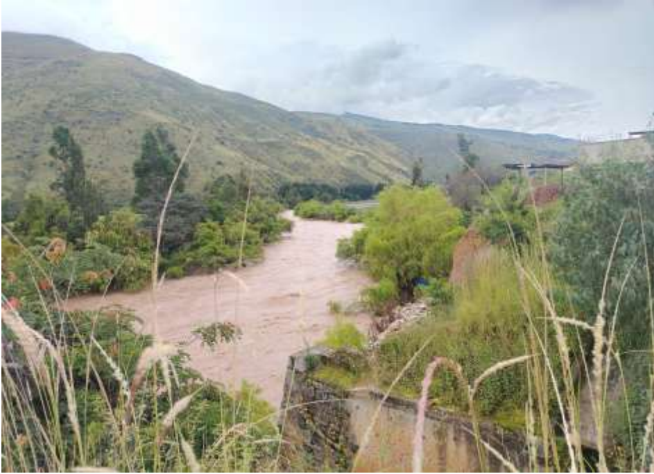
Figura 85. Punto de vertimiento.
