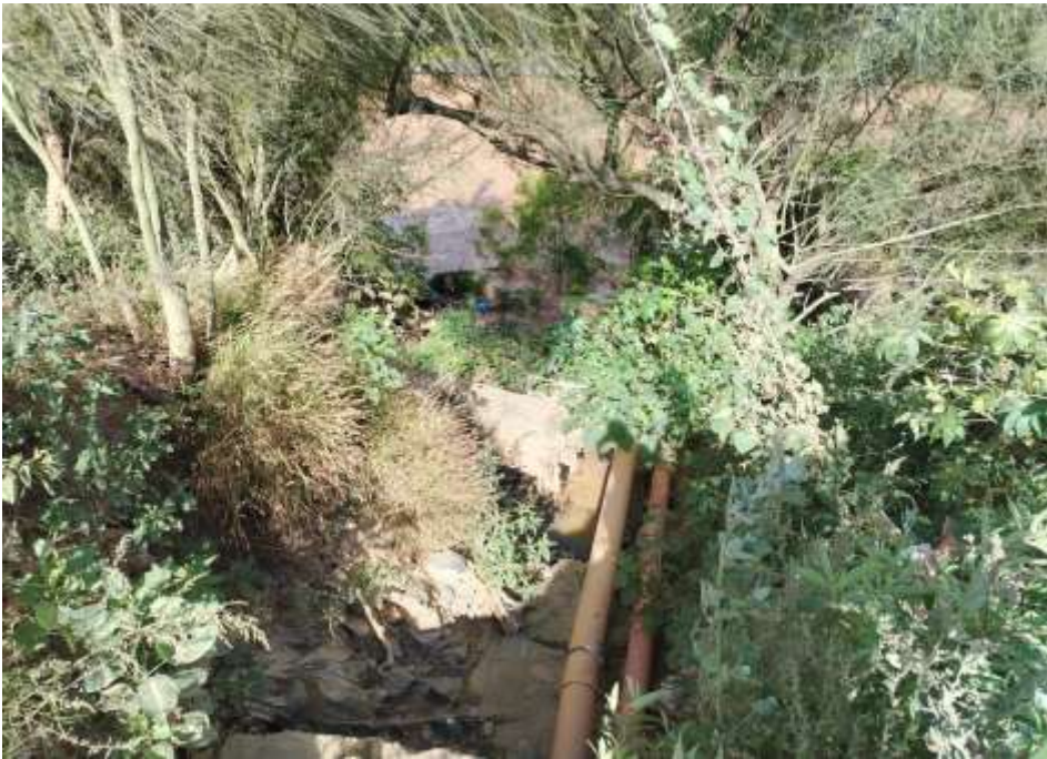
Figura 92. Punto de vertimiento.
