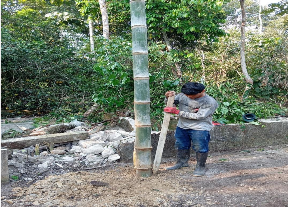
Figura 26. Instalación de la estructura para el compostaje.
