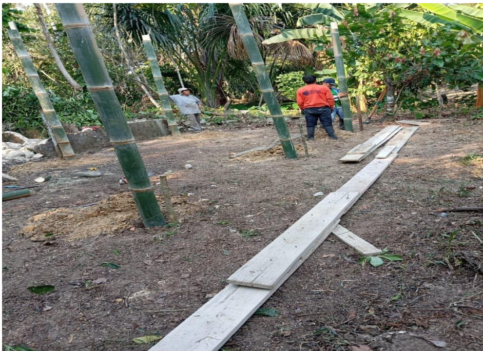
Figura 25. Instalación de la estructura para el compostaje.
